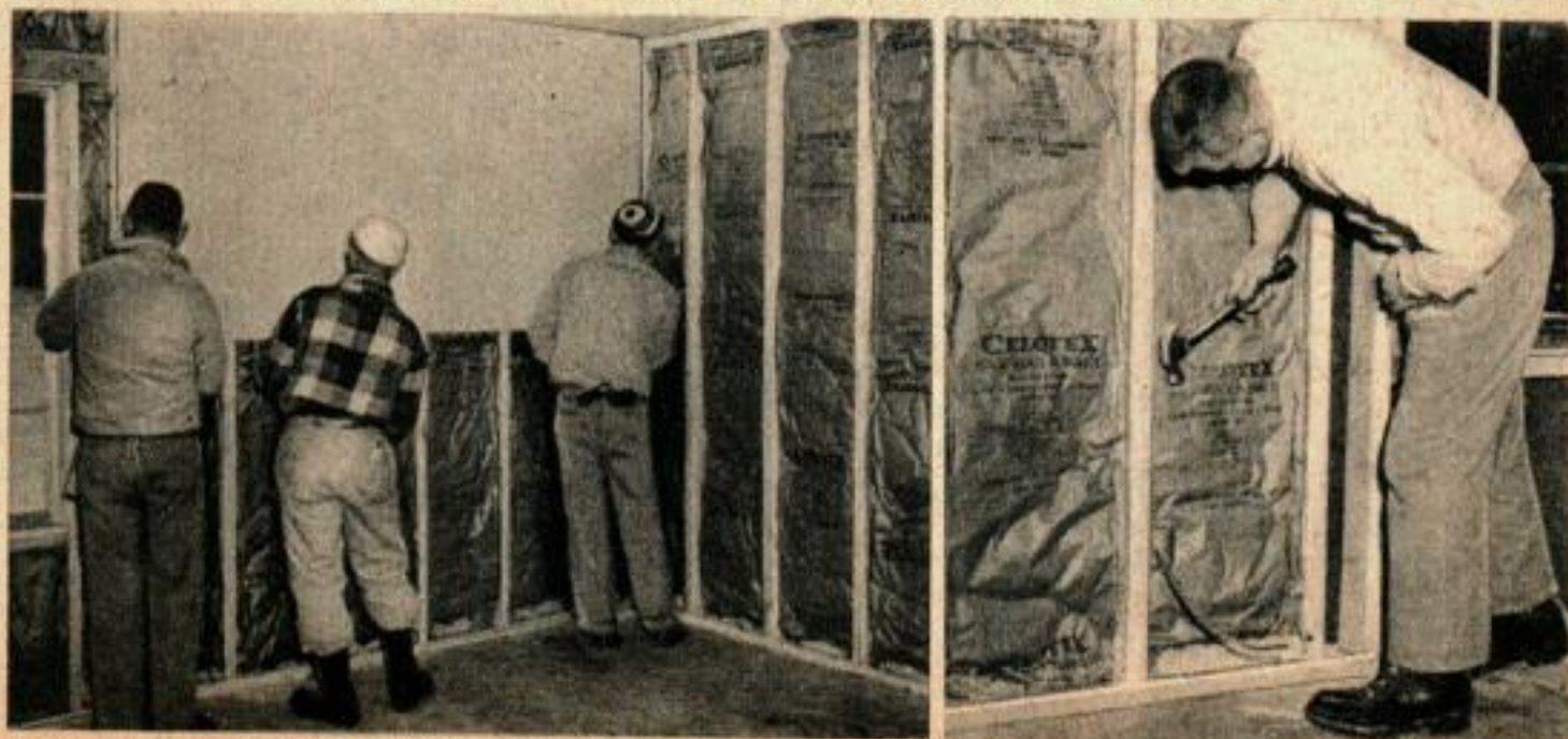
Les matériaux de construction doivent être à portée de la main, mais sans encombrer le passage. A droite : Les feuilles isolantes sont clouées entre l'extérieur des parois et le câblage.
