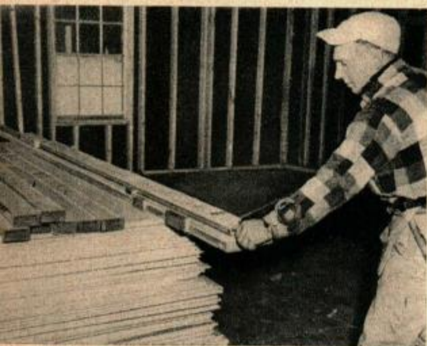
Ci-dessus : Mise en place des panneaux de « lattis » préfabriqués sur la face interne des murs extérieurs. Les plaques sont poussées très serrées contre le « lattis » du plafond.
