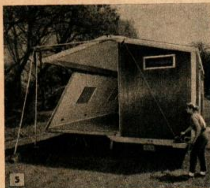
5 La photo ci-dessus, prise en direction de l'arrière de la remorque, montre l'érection de la section murale au même stade que sur la photo de gauche.
