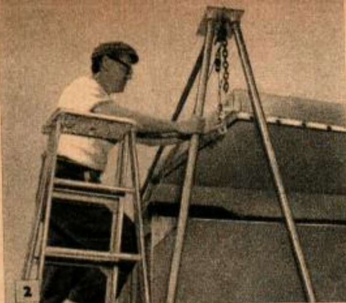
2 Les supports doubles installés aux angles supportent le toit et la section murale de 10,65 m pendant le pliage ou le dépliage de la remorque. Ces supports sont livrés avec la roulotte.
