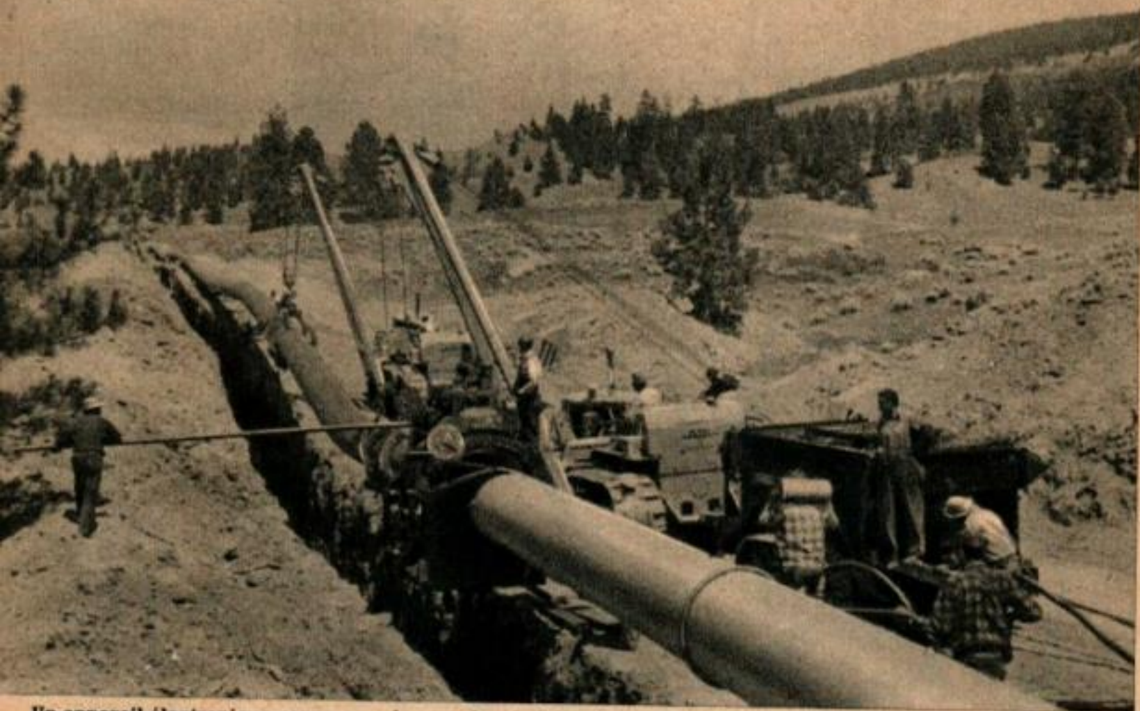
Un appareil électronique connu sous le nom de « holiday detector » est déplacé le long du tuyau pour rechercher les points faibles éventuels de l'enduit ou de l'enveloppement.
