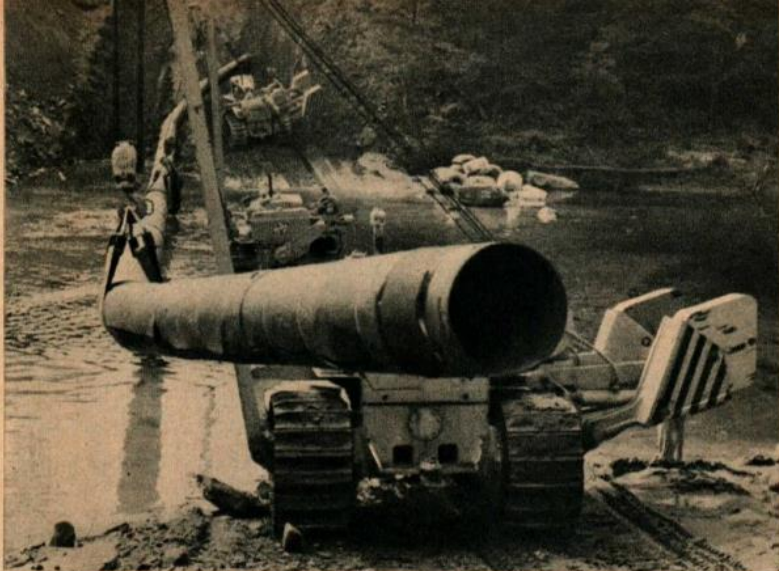
Des tracteurs Diesel équipés de bras de charge latéraux mettent un pipe-line en position pour la traversée d'une rivière de Pennsylvanie.
