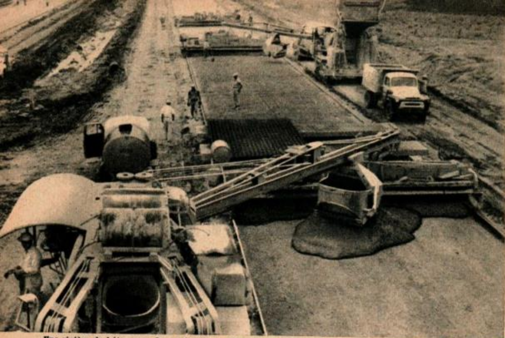
Une rivière de béton sans fin est étalée par l'équipe de revêtement routier de 24 hommes. Les chauffeurs des camions et voitures de l'équipe reçoivent leurs instructions par radio.
