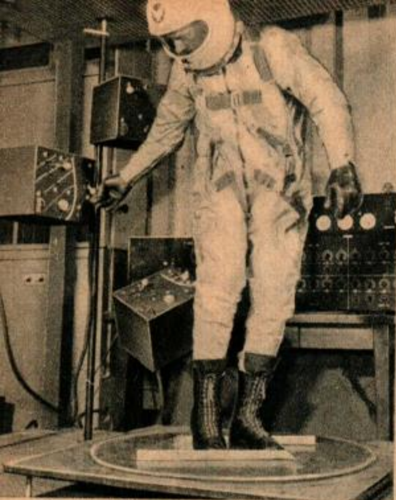
Le sujet de l'expérience, qui se tient debout sur un disque, flotte littéralement sur un coussin d'air comprimé tandis qu'il essaie d'actionner un interrupteur.
