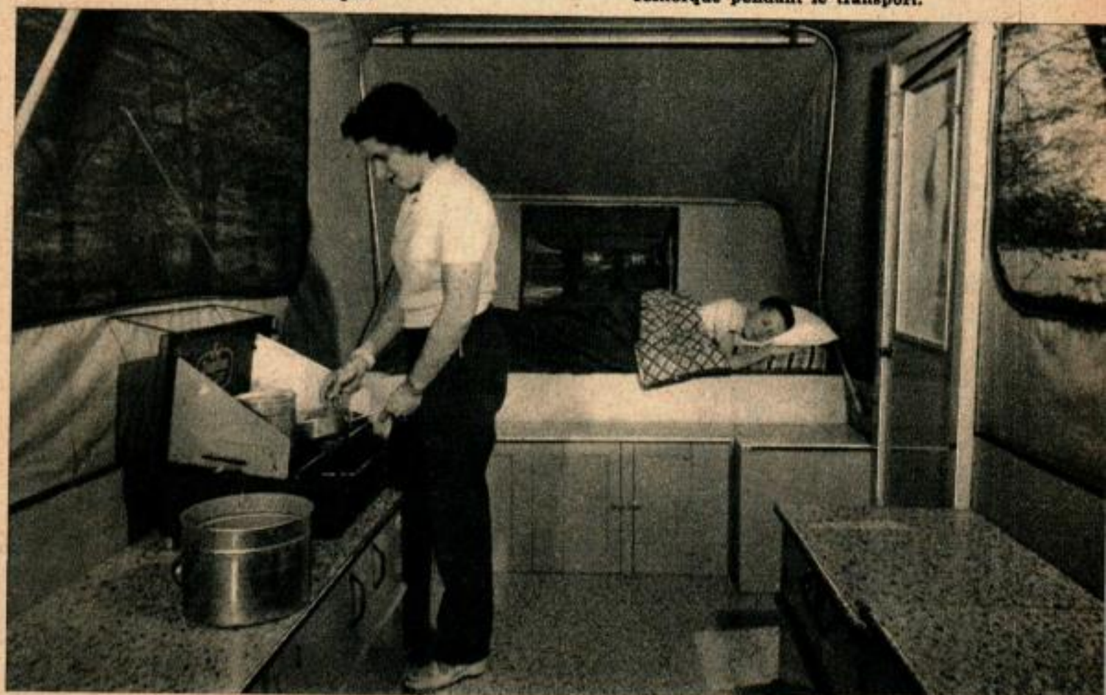
Ci-dessous : La netteté et le dégagement spacieux de l'intérieur de la remorque sont obtenus par l'installation des couchettes à l'extérieur de la caisse elle-même. Des fenêtres sont aménagées sur les quatre côtés et les dessus de placard servent, soit de surface de travail, soit de sièges.
