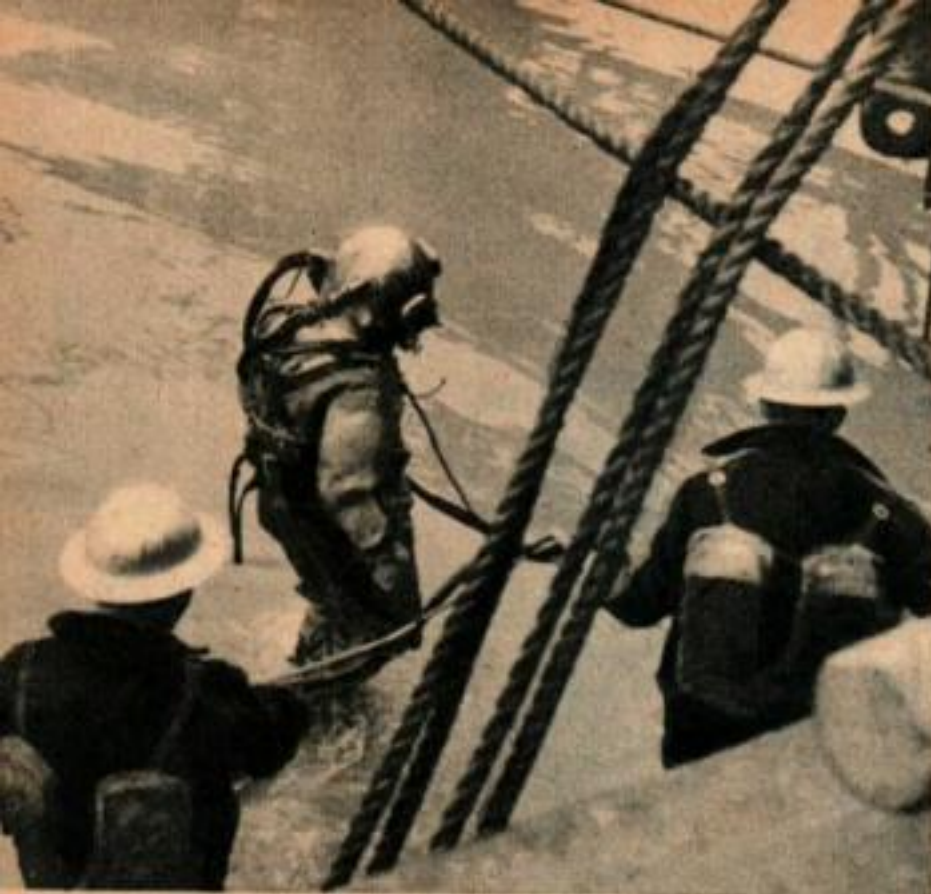
Les scaphandriers ont joué un rôle important dans la mise en place des sections du tunnel.
