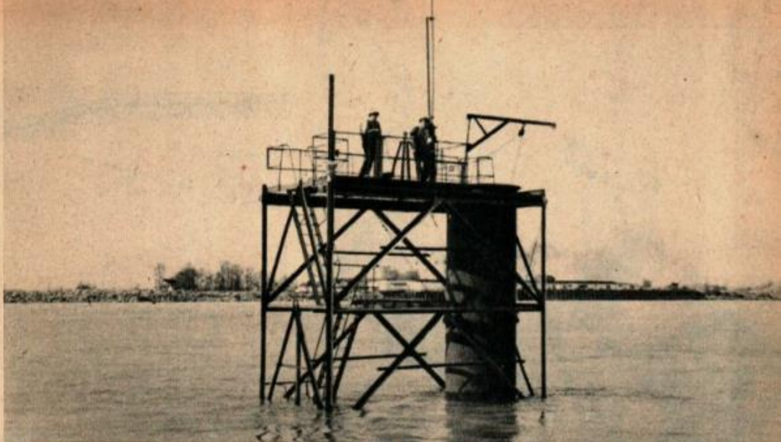
Des conduites de 21 m furent montées sur les secteurs du tunnel avant de les envoyer par le fond. À droite : les pointillés indiquent l'artère de circulation principale passant par le tunnel.
