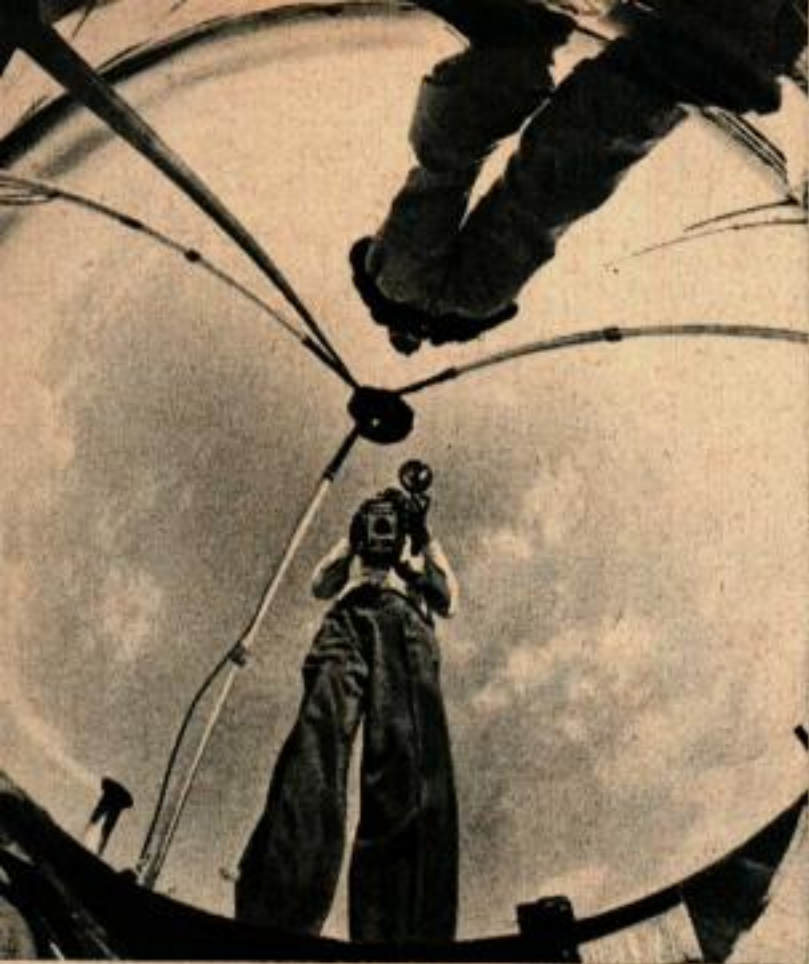
Une hémisphère argentée est utilisée comme objectif à grand angle pour la prise de photographies du ciel. L'appareil enregistre les conditions de formation des nuages.
