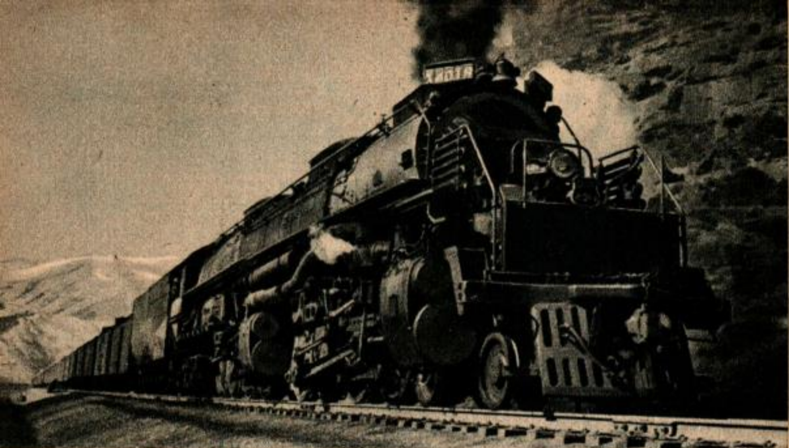
Une machine de la série « Big Boy », l'une des classes de locomotives à vapeur les plus puissantes qui aient jamais été construites. Leur puissance était étalonnée à 8 000 ch.
