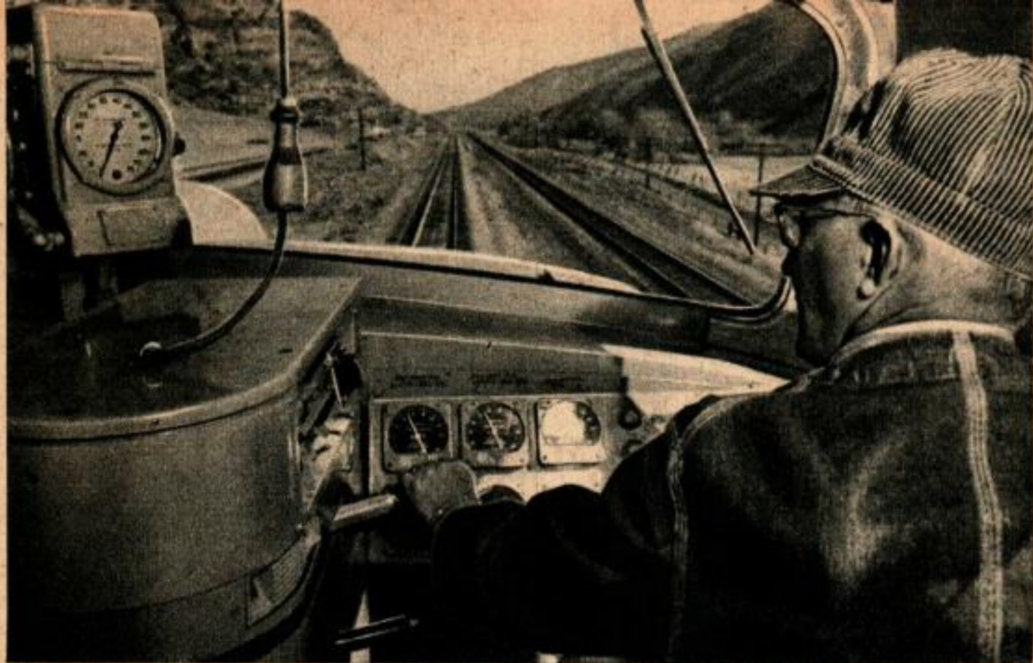
Le mécanicien se dispose à faire démarrer le train en tirant vers l'arrière la manette des gaz. Trois manomètres indiquent la pression d'air dans les réservoirs d'air comprimé et dans les autres éléments du système de freinage. Le cadran que l'on voit en haut à gauche, derrière la corde du sifflet, est celui du compteur de vitesse.
