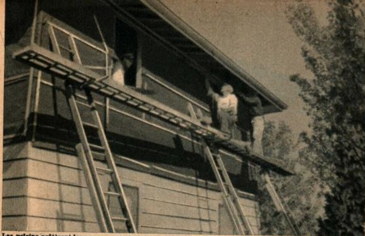
Les voisins prêtèrent leur concours pour la pose du revêtement des murs. Le large surplomb du toit améliore l'aspect général de la maison.
