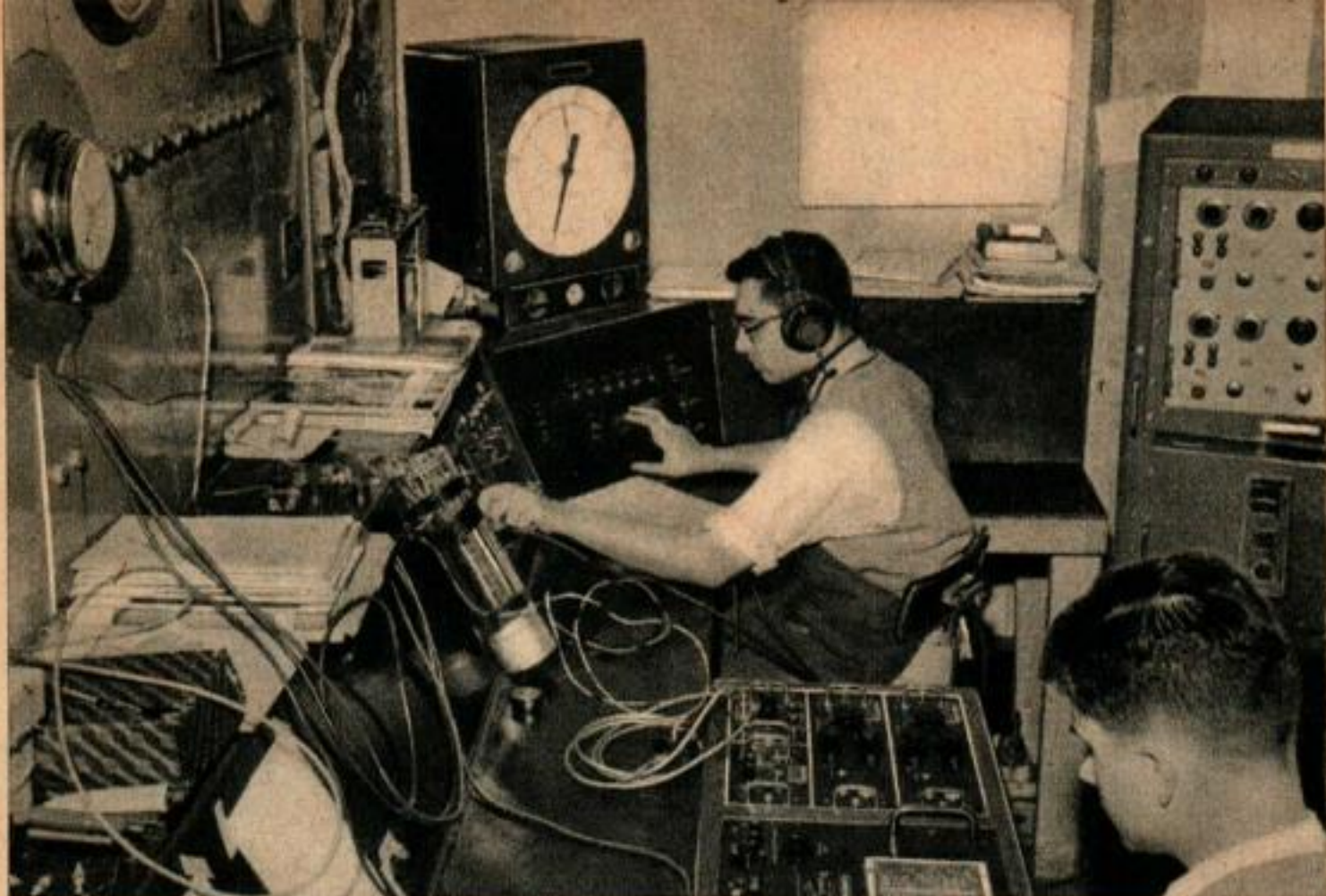
Les étudiants de l'Institut de Technologie du Massachusetts expérimentent les moteurs de fusées qu'ils fabriquent eux-mêmes, au moyen de ces divers tableaux de commande.
