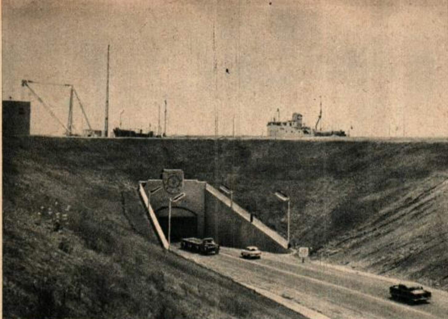
Un tunnel routier permet aux camions et automobiles de passer au-dessous des navires se trouvant dans l'écluse Eisenhower sur le canal de Willey-Dondero.
