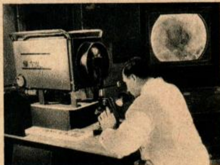
La télévision en couleurs est adaptée à l'étude microscopique des tissus. L'image est transmise aux docteurs ou étudiants se trouvant dans une autre salle.
