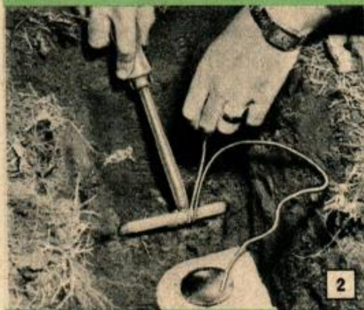
2 Le fil conducteur partant de l'anode est soudé sur la surface nettoyée d'une tubulure d'arrosage (fig. 3 et 4). Lorsque l'anode a été enterrée avec le matériau absorbant, celui-ci est saturé d'eau et le tout est entièrement recouvert avec de la terre.
