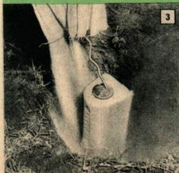
2 Le fil conducteur partant de l'anode est soudé sur la surface nettoyée d'une tubulure d'arrosage (fig. 3 et 4). Lorsque l'anode a été enterrée avec le matériau absorbant, celui-ci est saturé d'eau et le tout est entièrement recouvert avec de la terre.
