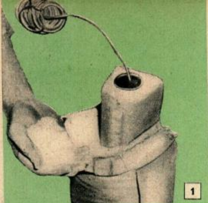
1 L'anode de magnésium est enveloppée dans une couche d'un matériau absorbant rapidement l'humidité, avec lequel elle est enterrée. Ce matériau reste imprégné de l'humidité du sol et il assure l'évacuation constante du courant électrique.
