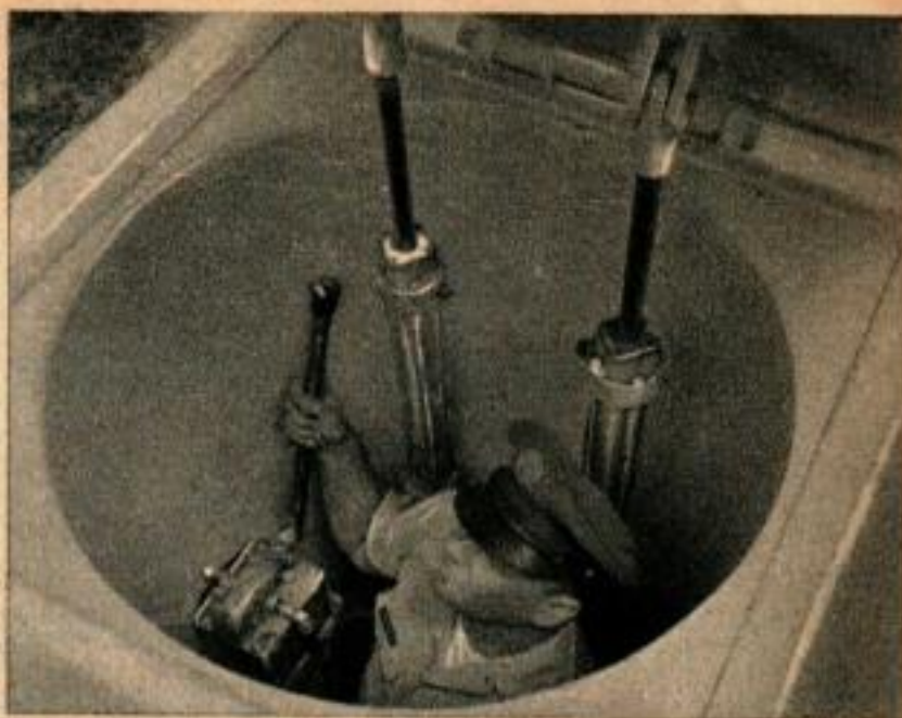
Un technicien de l'Air Force actionne une pompe manuelle pour ouvrir une écoutille de sortie de secours. Un blockhaus pour fusée Atlas, ci-dessous, se trouve partiellement au-dessous du niveau du sol.
