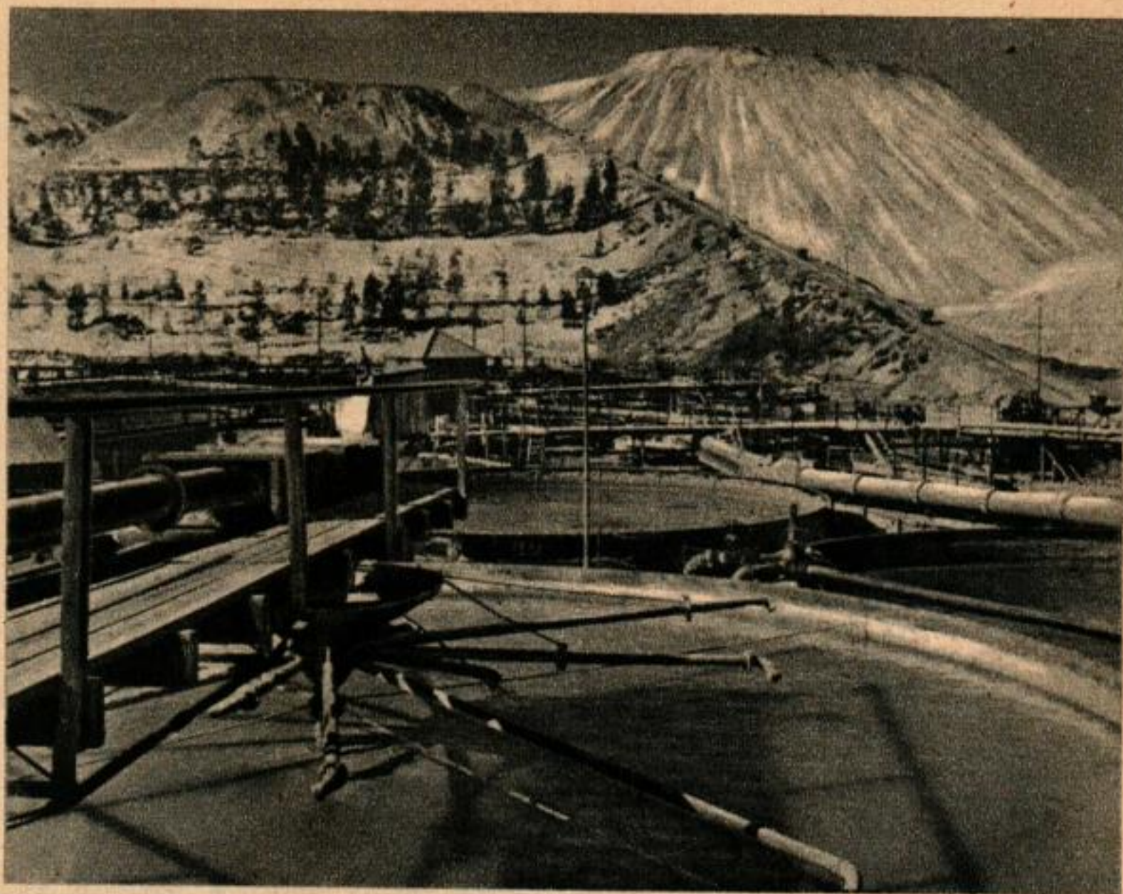
L'énorme montagne que l'on voit derrière cette mine vieille de soixante-quatre ans est artificielle. Elle est faite de millions de tonnes de roches dont l'or a été extrait.
