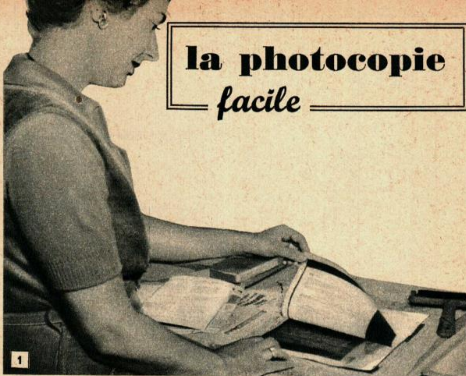
Lorsque le « sandwich » négatif-positif a été parfaitement pressé avec le rouleau en caoutchouc, l'image est transférée sur la photocopie positive.
