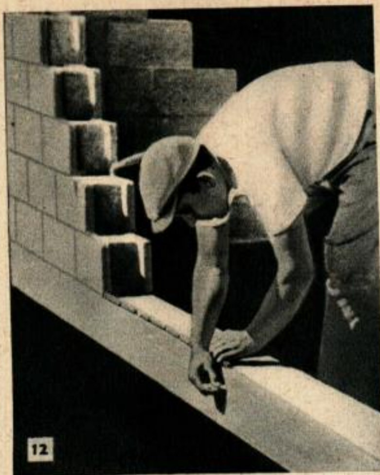
Le marquage de la fondation, ou la mise en place de blocs de béton sans mortier, indiquent l'espacement requis pour les blocs et indiquent également si un bloc recoupé devra être utilisé pour compléter la rangée entre les coins de mur préalablement construits.
