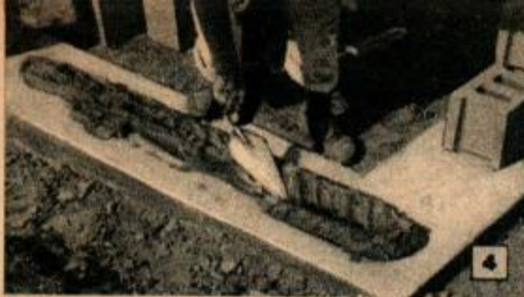
Un épais lit de mortier est étalé sur le mur de fondation pour recevoir la première rangée de blocs et lui assurer un maximum de solidité.
