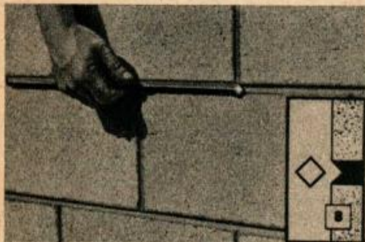
Lorsque les blocs ont été installés et que le mortier est encore malléable, un outil à former est utilisé pour lisser uniformément les joints.
