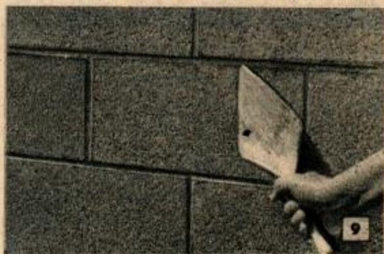
Au fur et à mesure de la mise en place des blocs, une truelle est employée pour enlever le mortier en excédent. Sa pointe sert aussi à tasser le mortier dans les joints.
