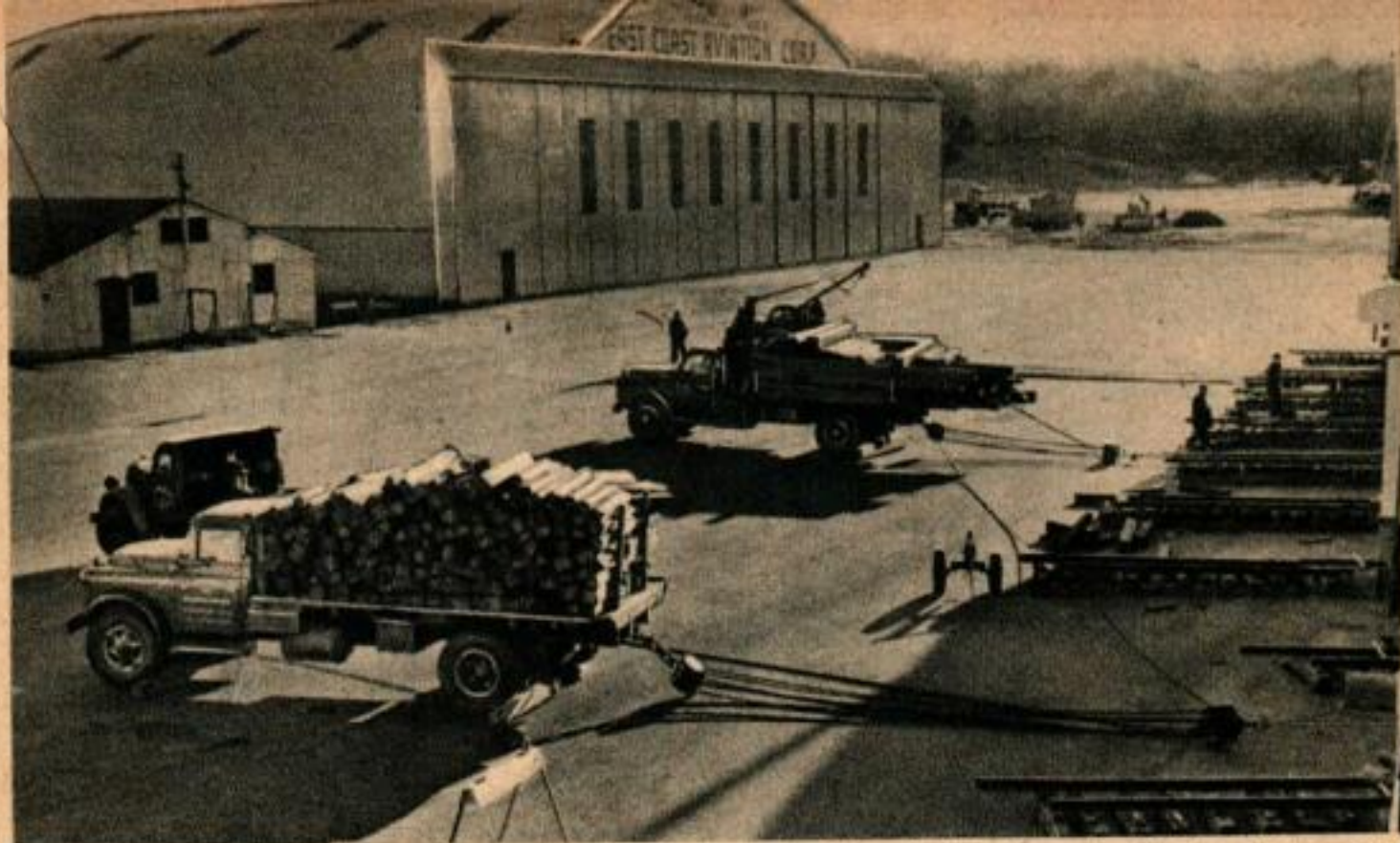
Ces camions de remorquage lestés qui se trouvent juste sur la « ligne de départ » sont prêts à tendre les câbles du système de poulies et moufles et à commencer à déplacer le hangar.
