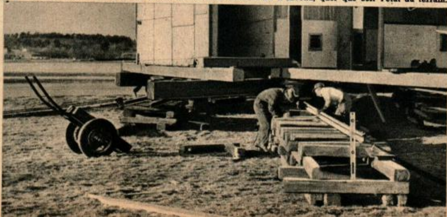
Les deux hommes ci-dessous sont en train d'ajuster la charpente de support des rails servant au déplacement du hangar. Les structures en bois bruts doivent être maintenues à niveau, quel que soit l'état du terrain.
