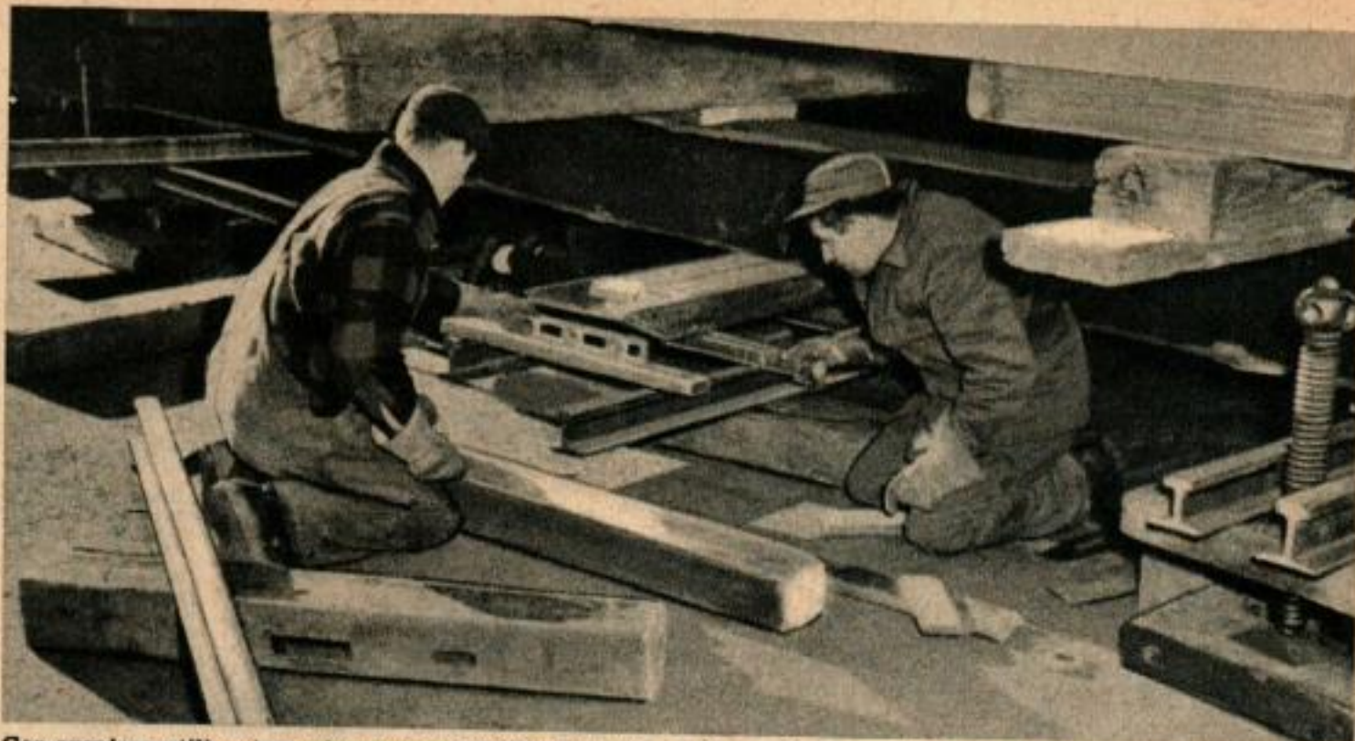
Ces ouvriers utilisent un niveau pour vérifier les rails sur lesquels voyage le hangar. Si ces voies n'étaient pas maintenues parfaitement nivelées, le bâtiment risquerait de se fissurer.
