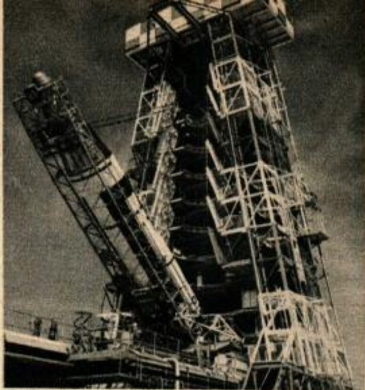
Les plates-formes de travail se trouvant au centre du pont roulant sont repliées vers le haut lorsque celui-ci roule sur sa voie ferrée pour s'éloigner de la plateforme de lancement de l'Atlas.
