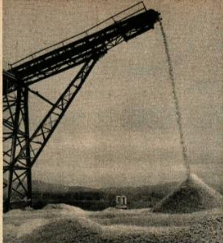
Lorsque le minéral a été miné sous forme de gros rochers, il passe dans un concasseur. Réduit à l'état de gravillon, il s'écoule sur un tapis roulant qui le dépose en une énorme pile. Le minéral est alors prêt pour l'expédition à l'usine de traitement.
