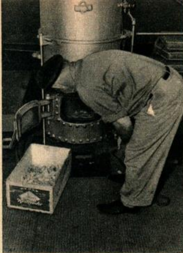
Hezzy allume le feu dans le foyer de la chaudière tubulaire verticale. Lorsque la pression est montée à 6,5 kg/cm 2 , le bateau est prêt à prendre le large.
