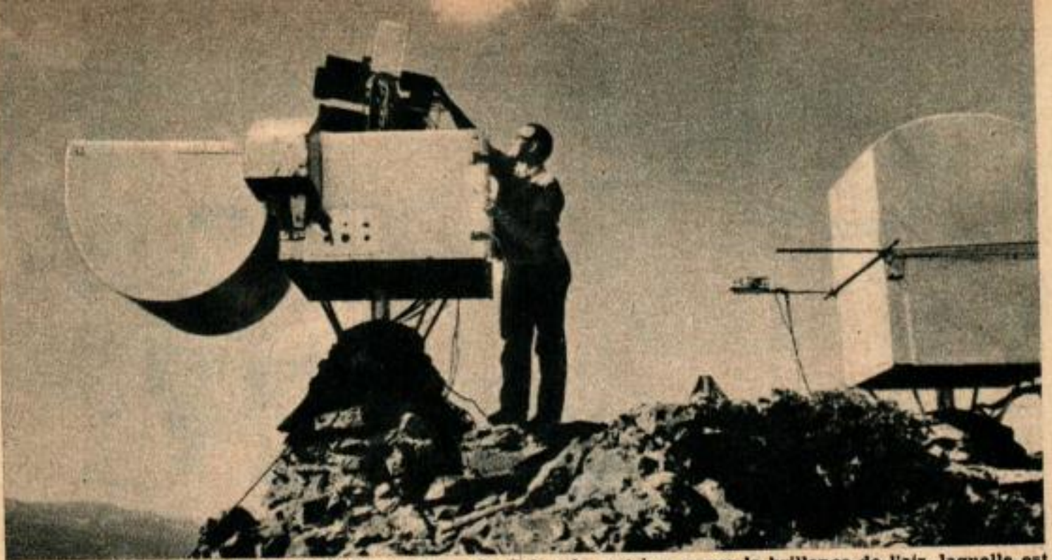
Cet appareil installé au sommet d'une montagne du Colorado sert à mesurer la brillance de l'air, laquelle est causée par un processus chimique qui se déroule dans l'atmosphère supérieure.
