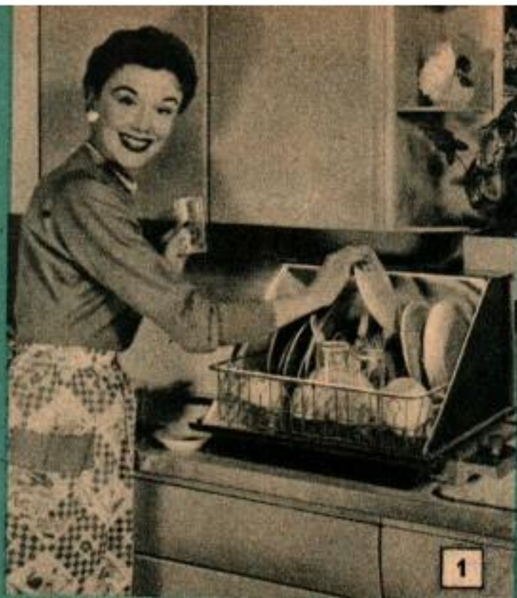
1. CETTE MACHINE A LAVER LA VAISSELLE portable à dispositif de lavage rotatif à double action peut laver et rincer la vaisselle pour une famille de cinq personnes. Elle pèse 5 kg, se branche sur le robinet d'eau et elle est conçue pour fonctionner avec des détersifs liquides.
