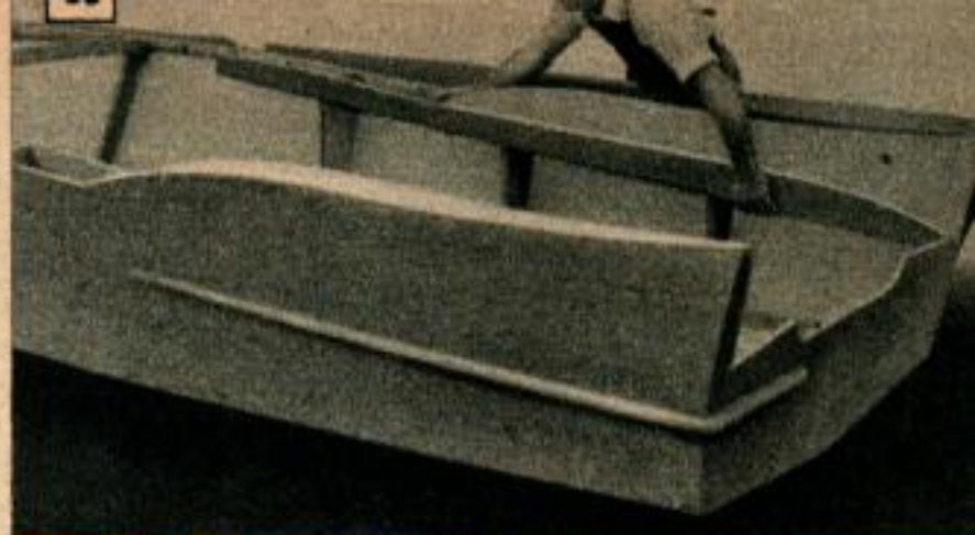
Fig. 35. — Mise en place de l'assemblage composé du bandeau et de la section intérieure de l'aileron de queue dans les encoches coupées dans les couples. Ci-dessous : carénage des membrures de support du pontage avant.
