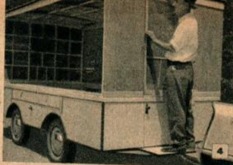
4 La deuxième phase consiste à répéter l'opération précédente pour la paroi se trouvant à l'autre bout de la remorque. L'installation peut se faire à un seul homme, mais elle est plus rapide à deux personnes.
