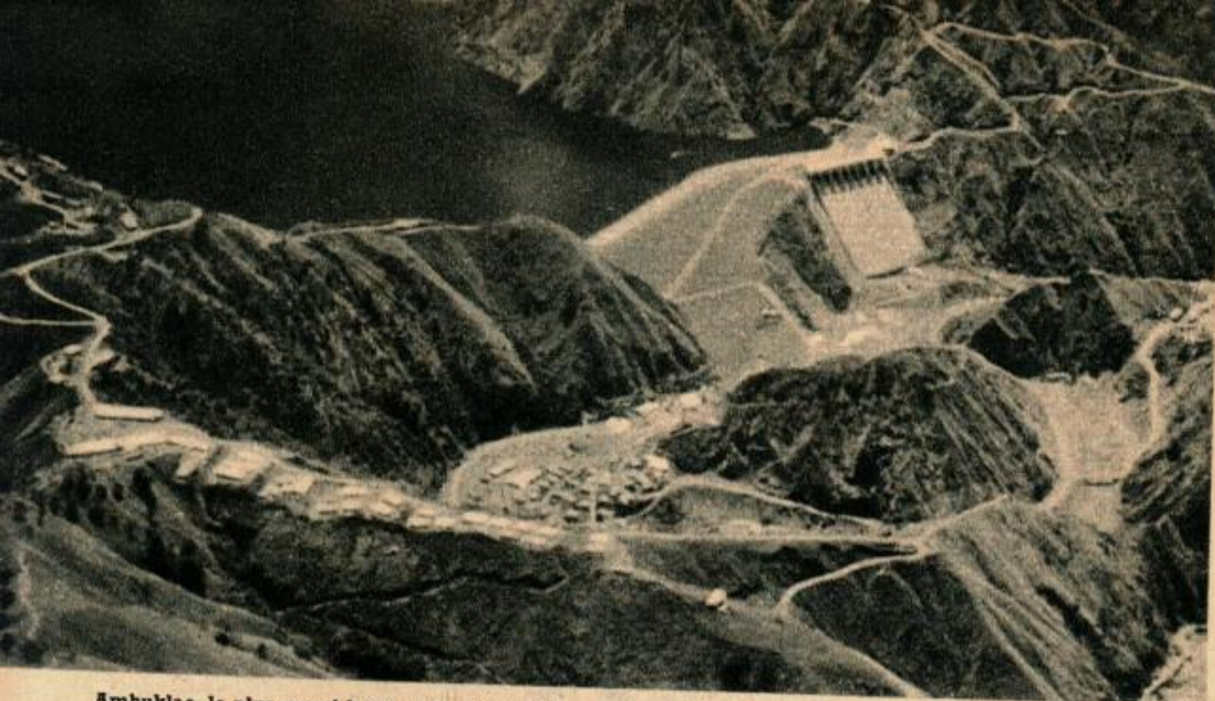
Ambuklao, le plus grand barrage en remblai du monde, a été terminé l'an dernier. C'est le premier d'une série de six qui seront situés dans le Nord de Luçon.
