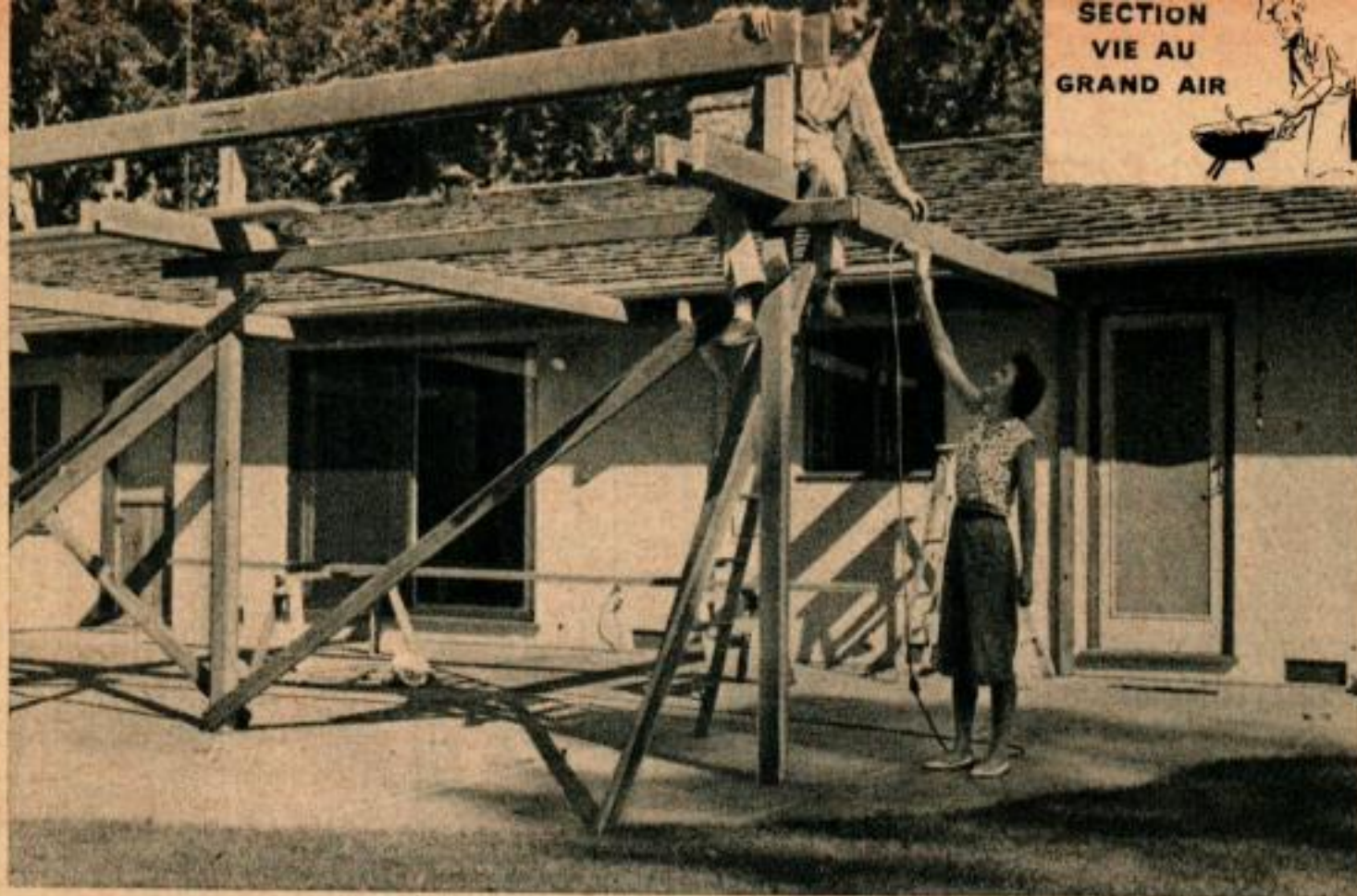
Au cours du montage de la charpente, Riley (assis sur le double chevron de 50 x 150 mm) se penche pour atteindre la perceuse que lui tend son épouse.
