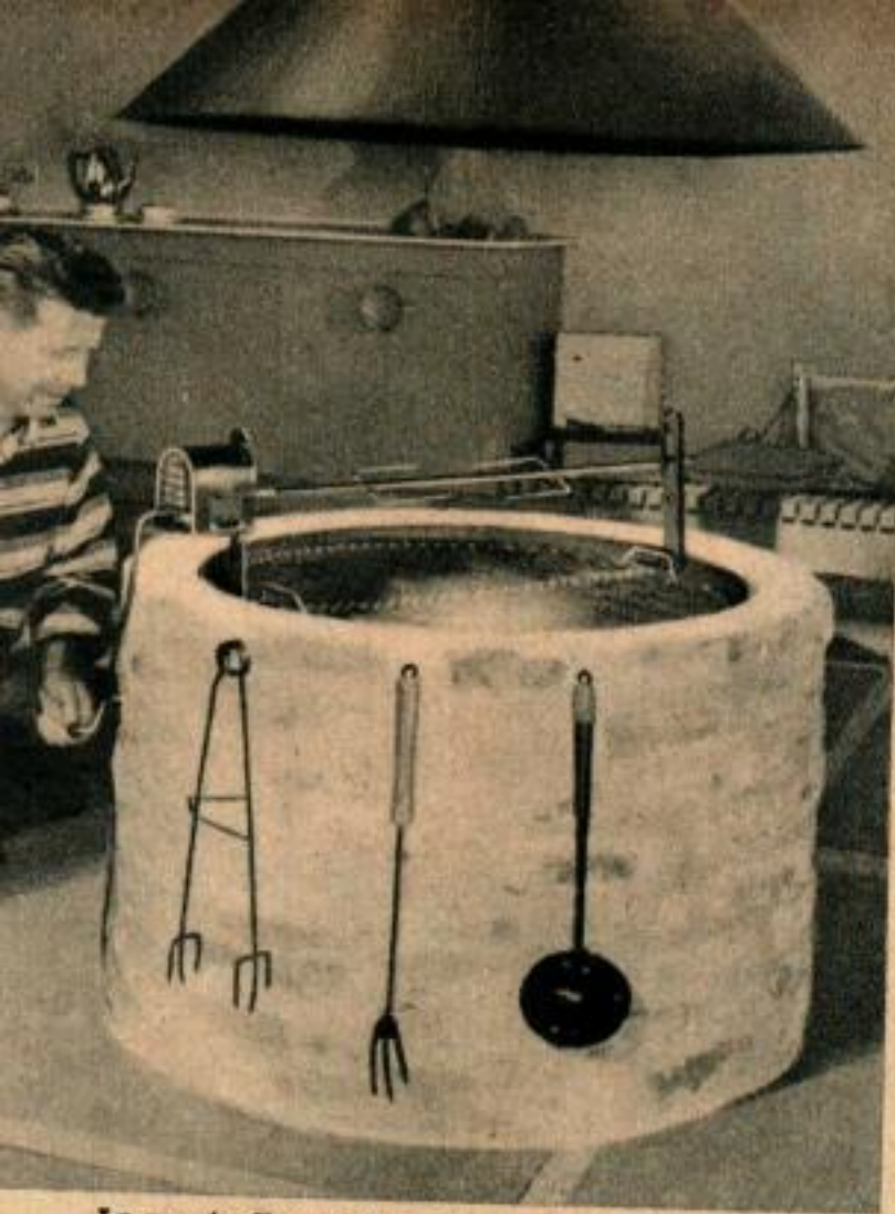
La manivelle que l'on voit sur le côté de la rôtisserie en plein air sert à élever ou à abaisser le grill. La maçonnerie de briques a été montée autour d'un grill portatif. Une hotte décorative avec gaine d'évacuation sert à éliminer la fumée.
