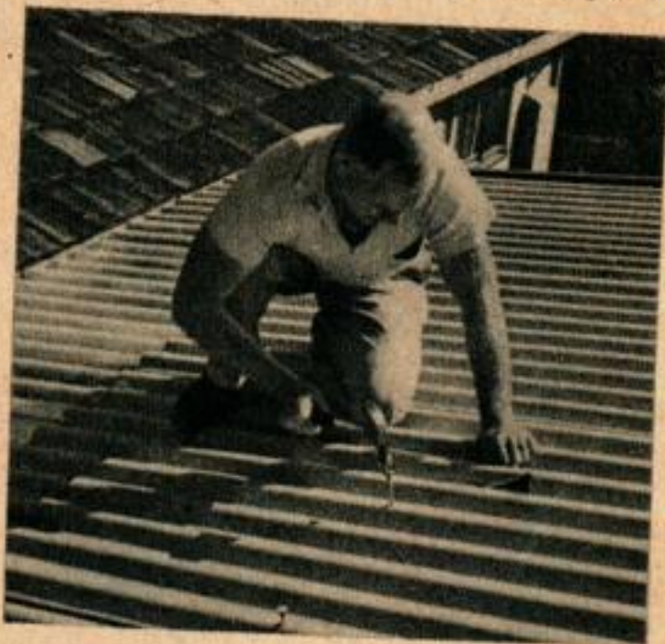
Le toit en « Flexboard » ondulé a été très facile à clouer sur la charpente. La section la plus proche de la maison est en fibre de verre translucide qui contribue à éclairer à la fois la maison et la salle de séjour extérieure. Riley a utilisé des panneaux de « Flexboard » en longueur de 3,65 m et des panneaux translucides en longueur de 90 cm.
