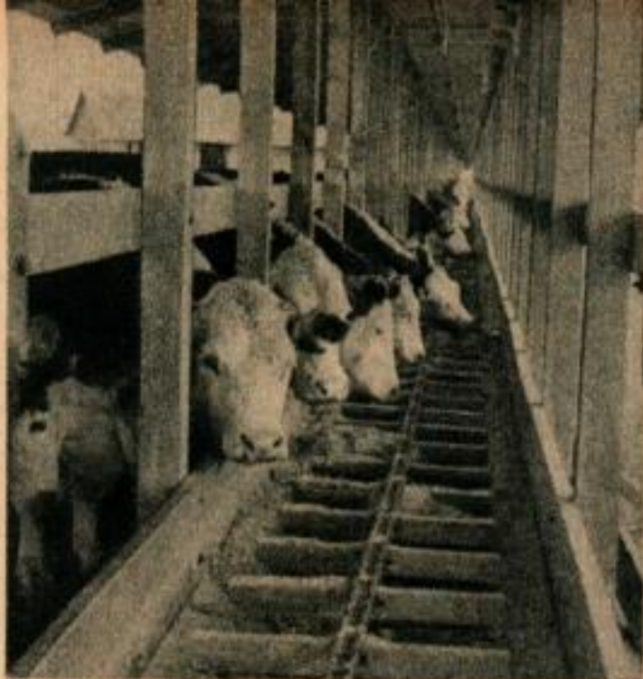
Cette « table de salle à manger » longue comme un pâté de maisons dessert 500 bouvillons. Les aliments sont entraînés dans la mangeoire par un transporteur à chaîne et barres.
