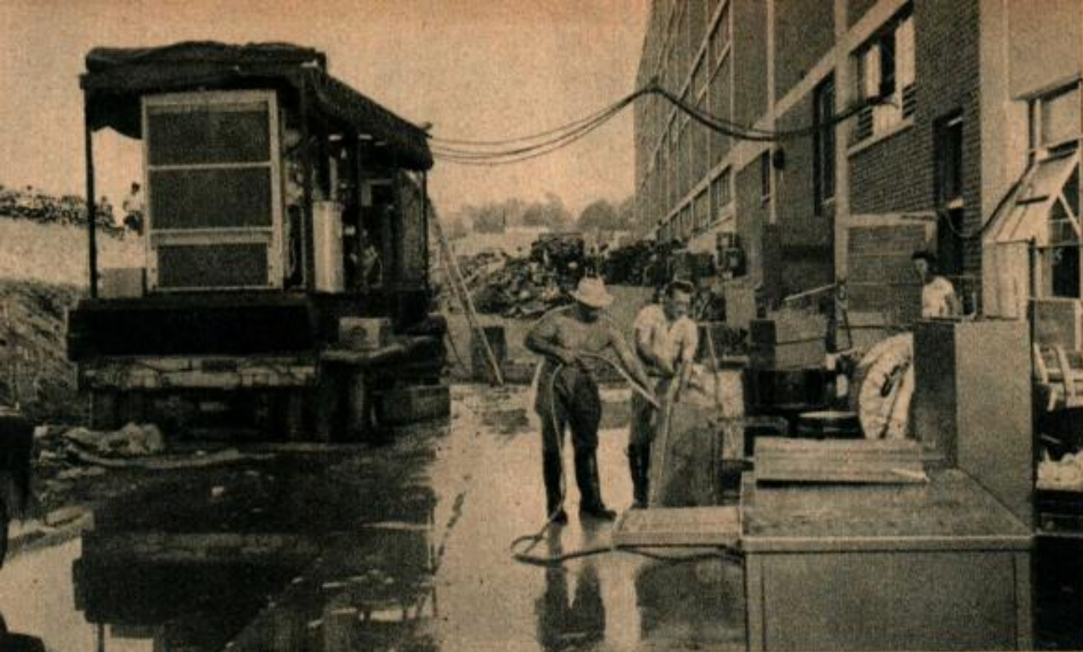
Ce groupe générateur mobile fournit du courant de secours qui a permis de récupérer une partie du contenu d'une usine de chaussures après l'inondation.
