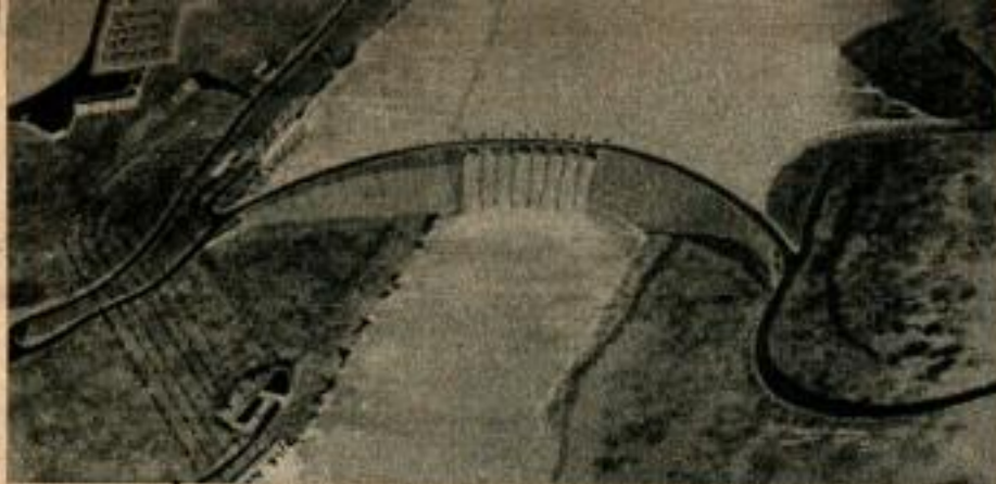
Voici le Barrage de Kariba tel qu'il apparaîtra lorsqu'il sera terminé. L'eau du Zambèze sera envoyée dans les prises d'eau et déversoirs indiqués par les lignes pointillées. Une route passera sur le sommet du barrage.
