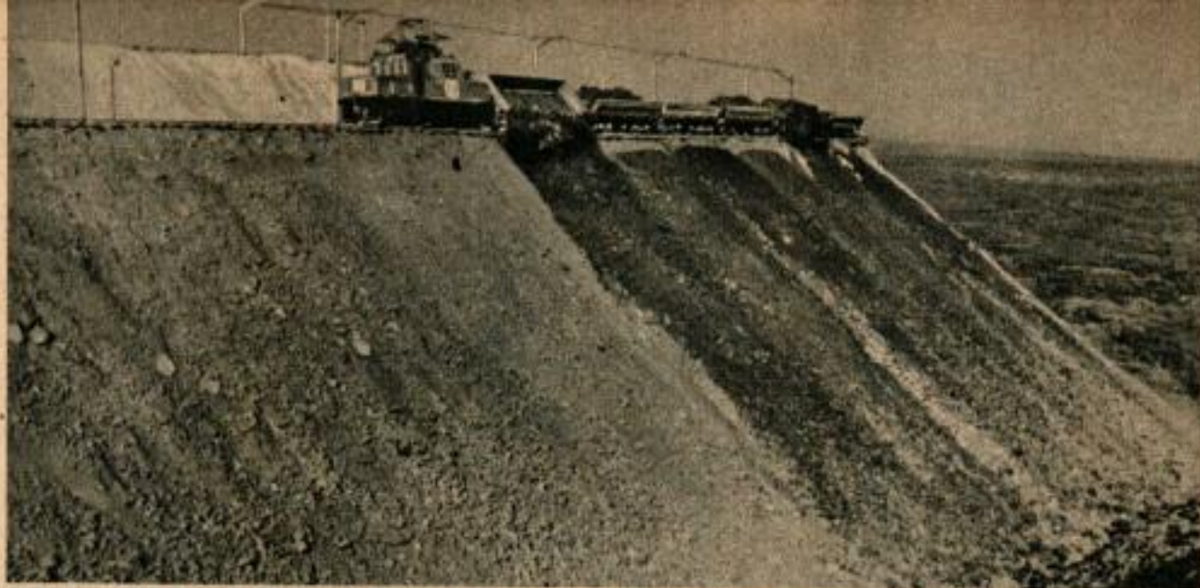
Cette mine de cuivre du Congo Belge ferait partie du projet hydro-électrique proposé pour cette colonie.
