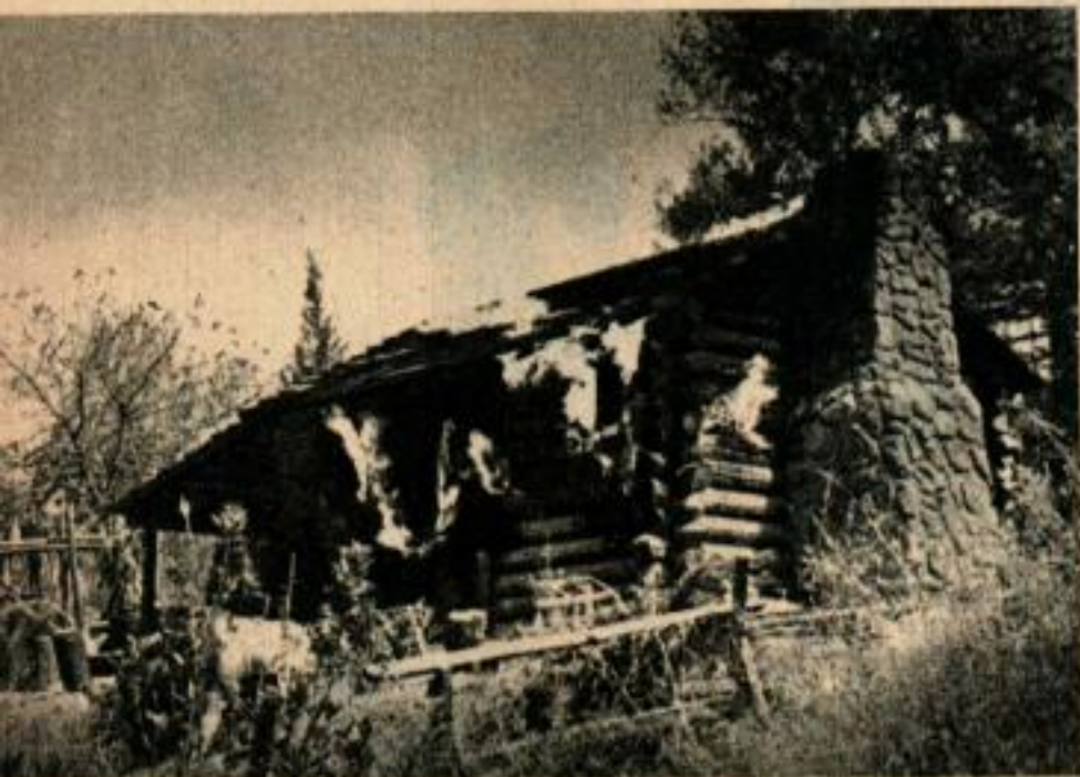
Cette ferme du Far West est abandonnée en flammes après l'attaque des Peaux-Rouges. Mais les flammes sortent en réalité de brûleurs à essence et le bâtiment est en béton.
