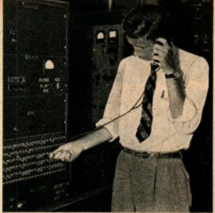
Cette série de commutateurs à bascule installée à la base du Poste de Transmission Vocale permet de sélectionner les mots utilisés dans les messages.
