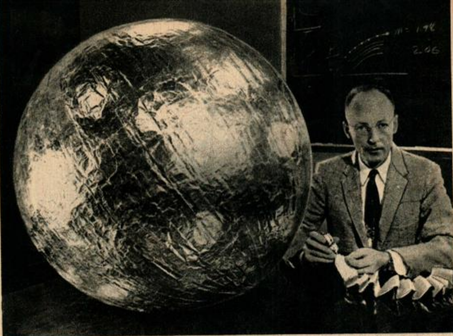
Le bébé-satellite gonflable est recouvert de papier d'aluminium. Un savant présente le ballon dégonflé et la cartouche de gonflage.
