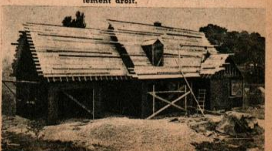
Quand les chevrons, les pignons et les pans de bois sont complètement installés, appliquez le reste du revêtement isolant, puis clouez le voligeage du toit, clouez les voliges jointives et laissez dépasser leurs extrémités. Lorsque les voliges seront posées, sciez les toutes ensemble afin d'avoir un bord de toiture parfaitement droit.
