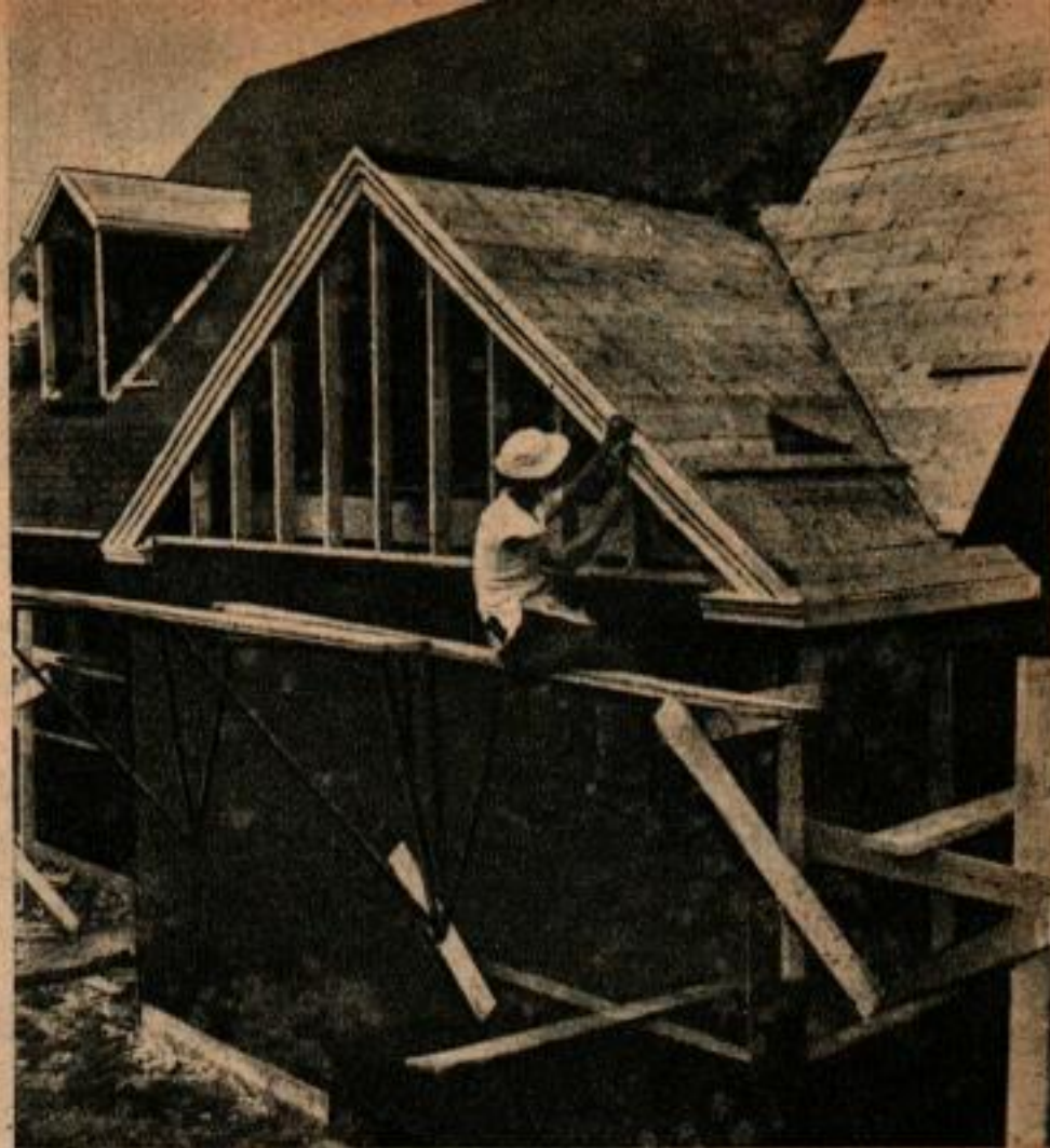
La photo ci-dessus vous montre comment le petit pignon de la façade de devant est installé sur la toiture. Il n'est pas utile de couper les chevrons du toit pour monter le pignon. La deuxième photo montre la pose des rives en bois sur le pignon.
