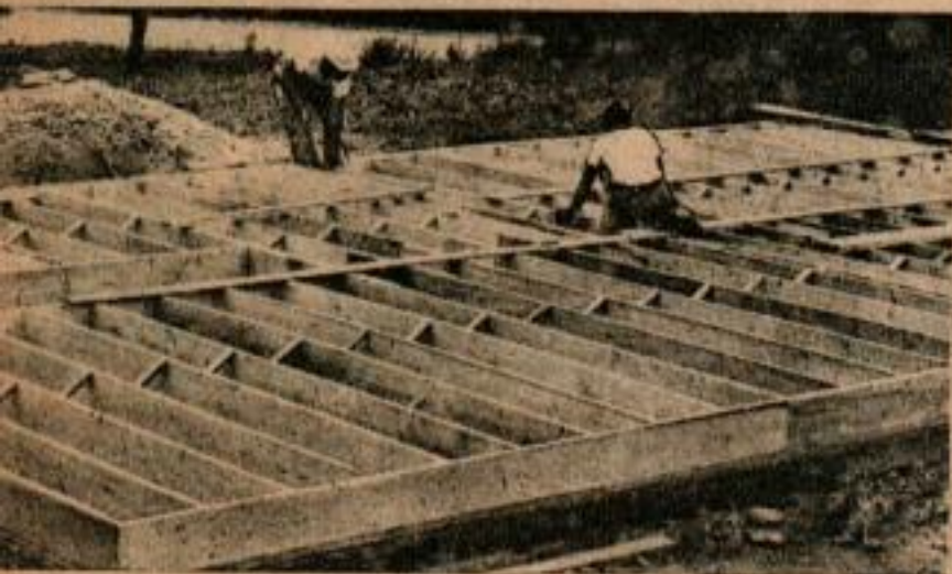
On pose ensuite les solives. Celles-ci se rencontrent et se recouvrent sur la poutre centrale. Elles sont posées sur une large sablière qui est boulonnée aux murs de fondation en béton.
