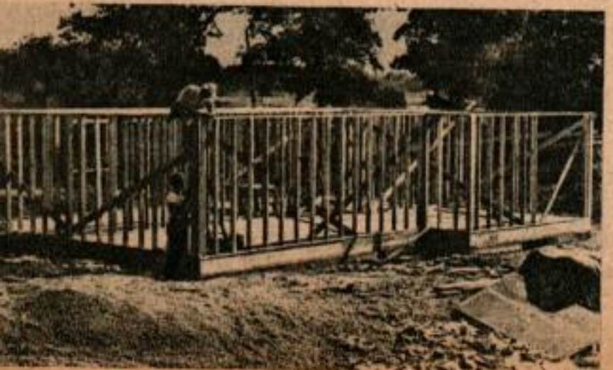
Le contreplaqué employé pour le coffrage du béton est posé sur les solives comme sous-plancher et le pan de bois est assemblé. Les poteaux sont montés en pans sur le sol et l'ensemble est ensuite mis en place. On doit utiliser trois poteaux à tous les angles afin d'augmenter la solidité de l'ensemble.
