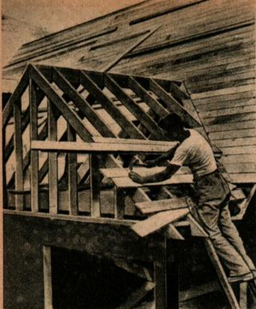
La photo ci-dessus vous montre comment le petit pignon de la façade de devant est installé sur la toiture. Il n'est pas utile de couper les chevrons du toit pour monter le pignon. La deuxième photo montre la pose des rives en bois sur le pignon.
