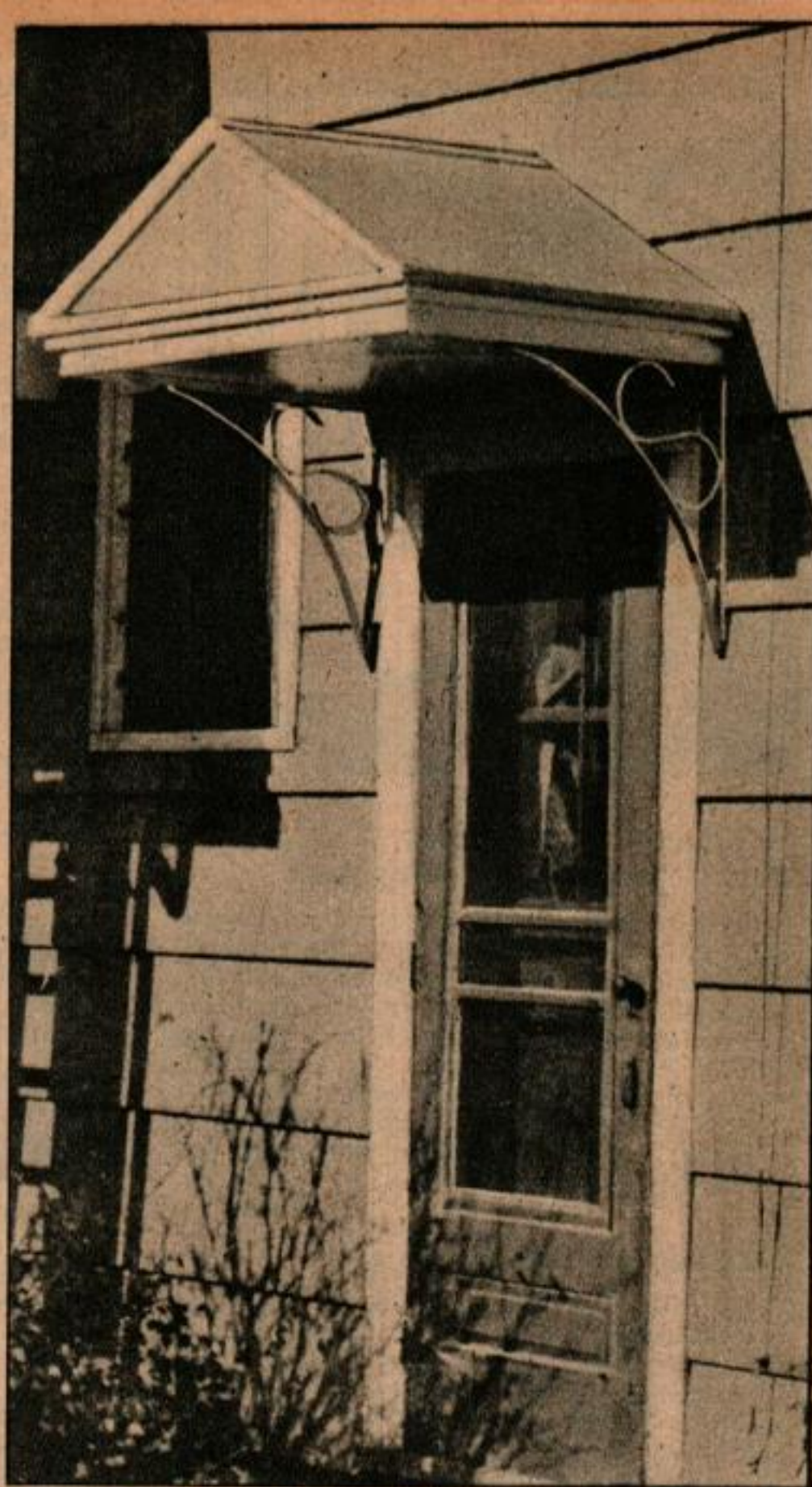
Marquise pré-fabriquée. — Protège les portes extérieures de la pluie et de la neige; apporte une note de galeté à la maison; s'installe en 20 min.
