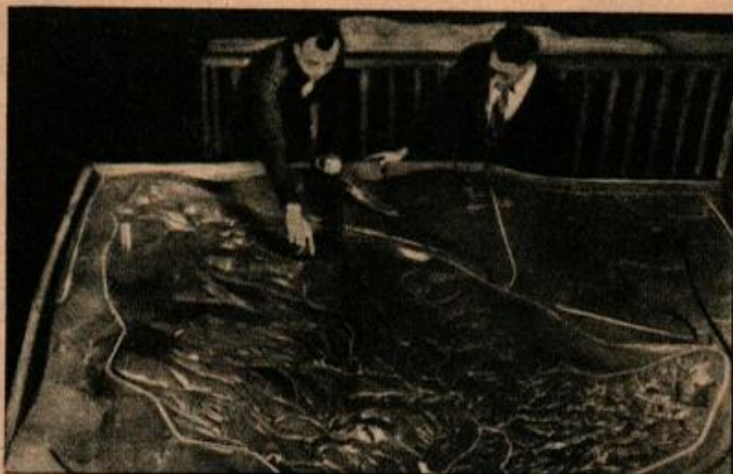
Les ingénieurs examinent cette maquette du bassin du Mississippi en construction près de Clinton (Miss.). La maquette terminée représentera 31 Etats.
