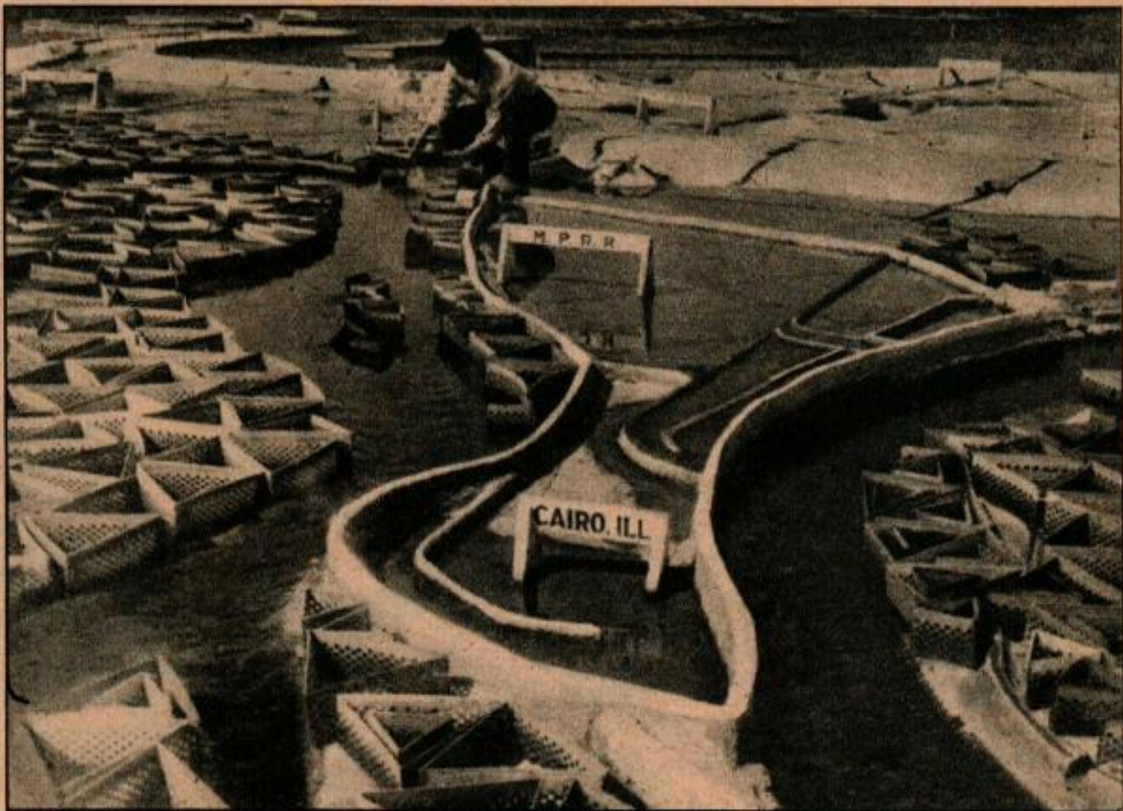
Le majestueux et puissant Mississippi est reproduit à échelle réduite dans cette maquette destinée à étudier la protection contre les inondations de la ville de Cairo (Etat de l'Illinois). Ci-dessous maquette d'essais du canal et des écluses de New-Jersey.
