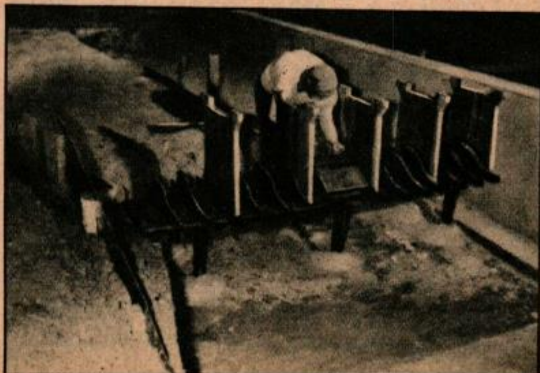
Un poids tombant dans un bassin à l'Université de Californie simulait l'explosion de la bombe atomique. Cet essai fait avant l'explosion de Bikini avait pour but de faire connaître si les vagues déferleraient par dessus l'atoll de Bikini. Ci-dessous squelette d'un appareil de commande d'une maquette de la station expérimentale des voies navigables des E. U. pour le projet de barrage contre les inondations de Morganza (Louisiane).
