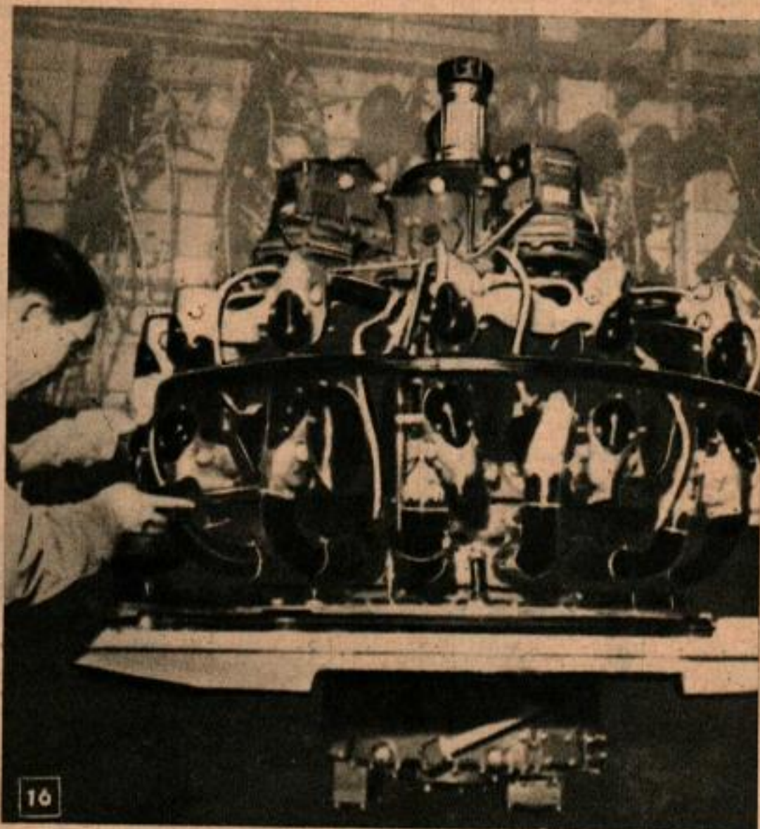
On approche de la fin de la révision, deux mécanos abaissent avec précautions les engrenages actionnant l'hélice. Ci-dessous un vérificateur donne un dernier coup d'oeil à un moteur flamboyant neuf qui était arrivé usé et en piteux état à la base aérienne de la Marine.
