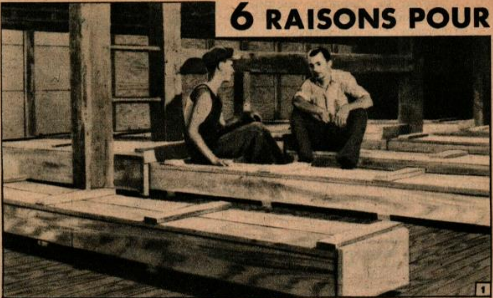
Voici une installation typique avec des conduites télescopiques qui partent du tunnel à vent qui se trouve à un bout de la meule.
