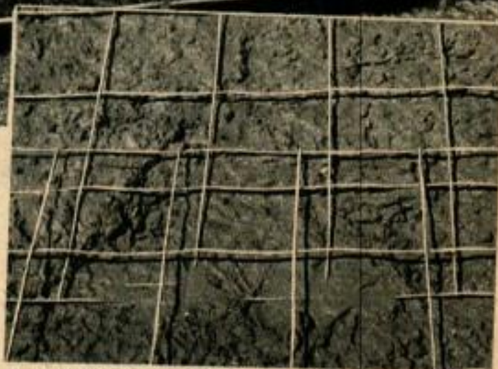
Pour les structures plates, telles que l'entrée de garage représentée ci-dessus, le grillage d'armature est généralement placé au milieu de la dalle, et ses bords se recouvrent, comme l'indique la photo encadrée de droite.
