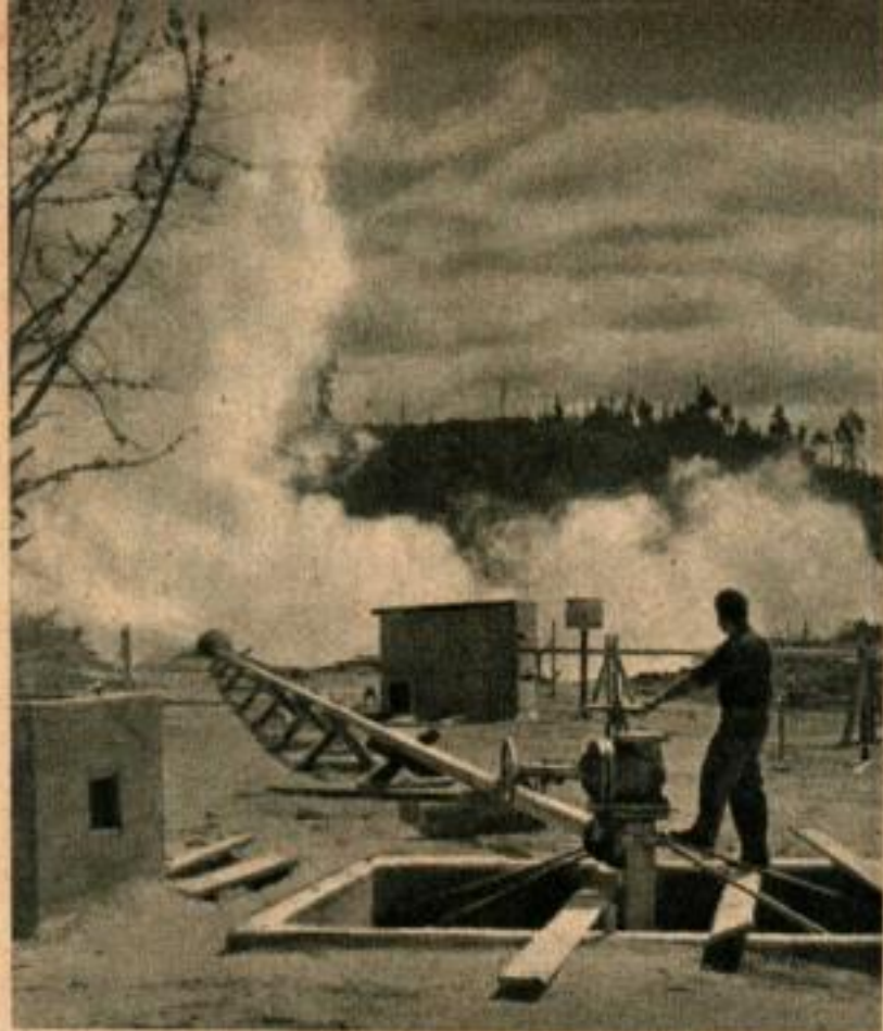
La vapeur sortant d'un puits dégagé est dirigée dans des tubulures horizontales et elle s'élançe sur près de 100 mètres à travers la campagne.
