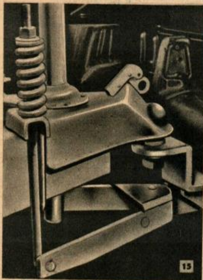
Ci-dessus: dispositif de remorquage se montant sur l'essieu arrière de la voiture, au moyen de brides. Ci-dessous: attelages à accouplement par chape et clavette et un modèle d'essieu avant auto-directeur.
