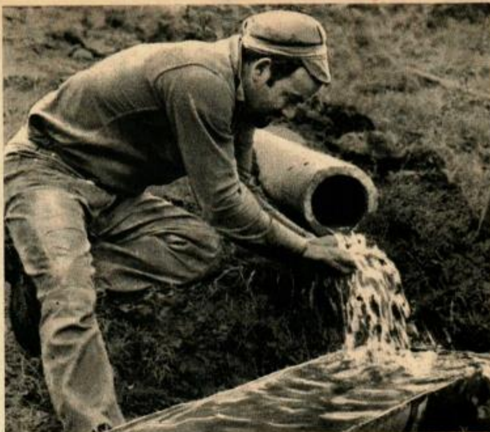
L'écoulement des puits horizontaux est continu car ils ne peuvent être bouchés, étant donné la forte pression exercée. Ci-dessous: un ouvrier rajoute un tube sur la perforatrice.
