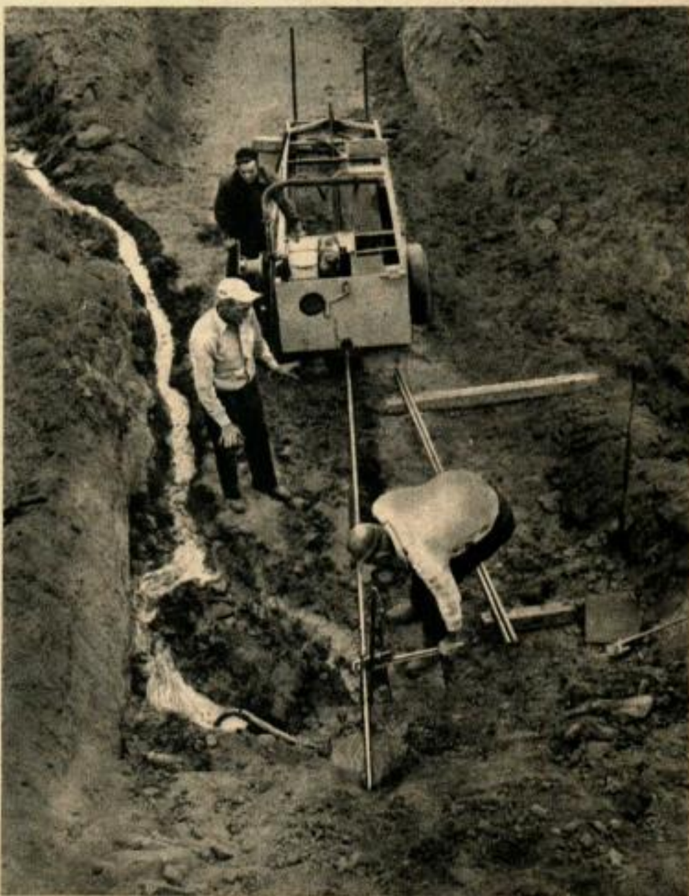
L'écoulement des puits horizontaux est continu car ils ne peuvent être bouchés, étant donné la forte pression exercée. Ci-dessous: un ouvrier rajoute un tube sur la perforatrice.
