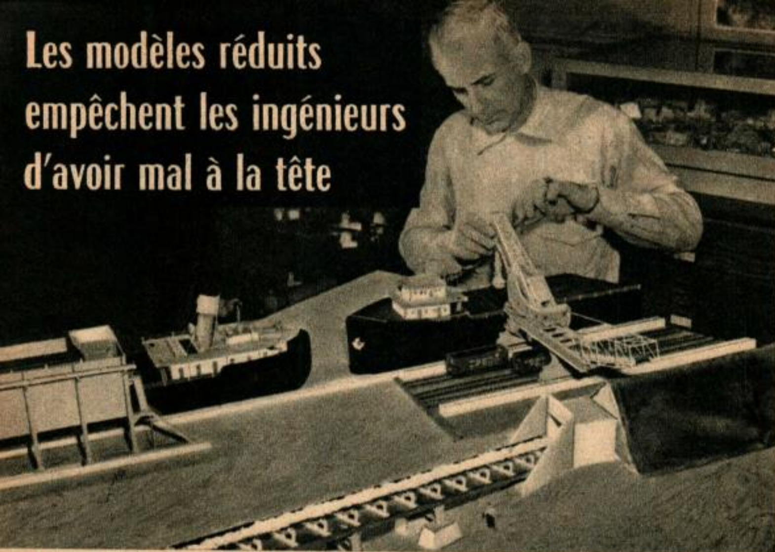
Tisen monte le modèle réduit d'un appareil à décharger le minéral. Celui-ci fait partie du modèle réduit d'une bande transporteuse de minéral traversant l'Ohio. Ce modèle a 5,40 mètres de long.
