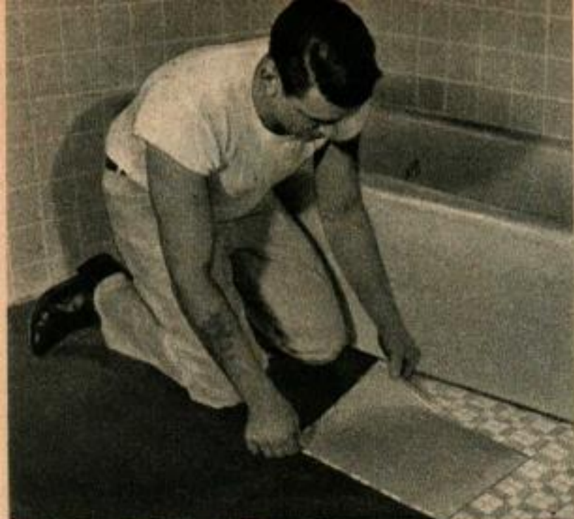
Lorsque les feuilles de mosaïque ont été alignées, elles sont forcées contre l'adhésif et mises à niveau avec un maillet et un bloc de pose spéciaux.
