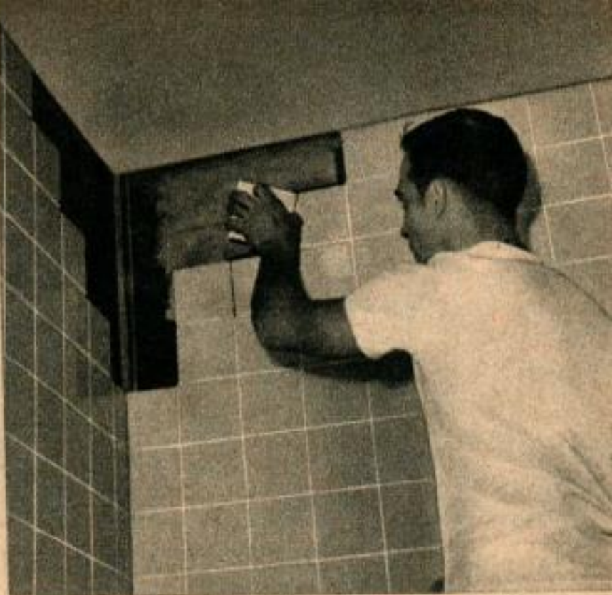
Les carrelages muraux sont forcés contre l'adhésif dans un mouvement de torsion. Les parties dépassantes des carreaux les placent automatiquement à l'espacement correct.
