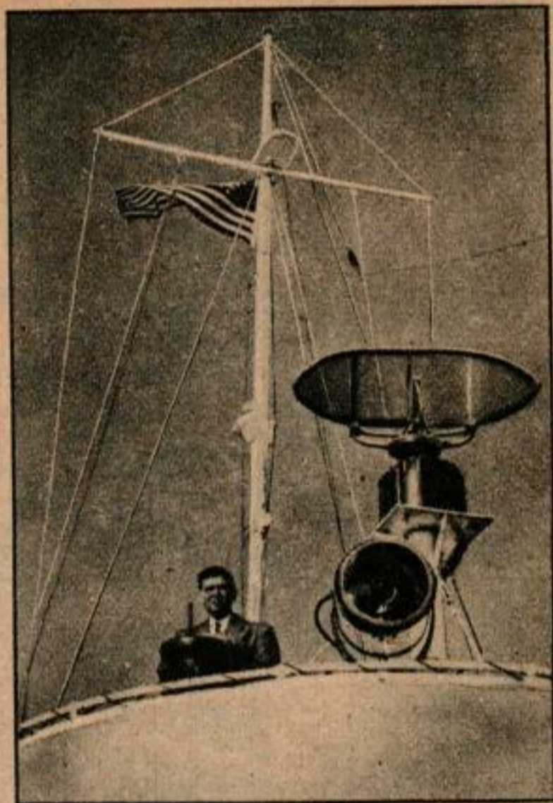
Ce projecteur de 50 cm de diamètre est commandé du poste de timonerie.
