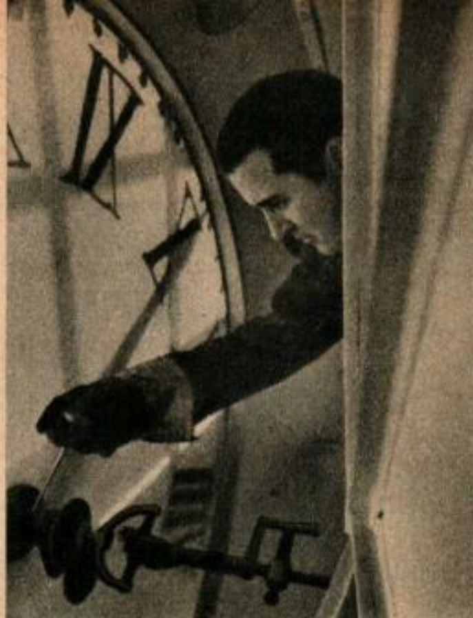
Derrière un cadran de verre, un ouvrier huile les engrenages de l'axe qui fait tourner les aiguilles à des vitesses différentes.
