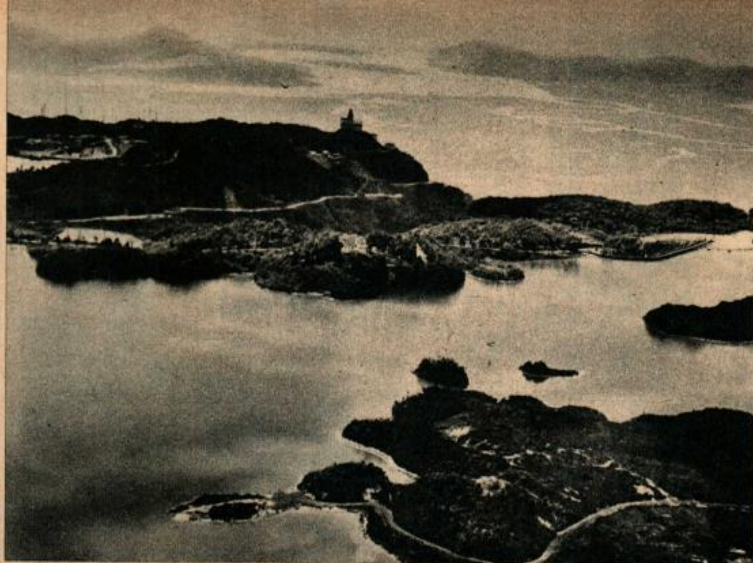
Des stations de pompage élèvent l'eau de trois rivières dans le « Billings Reservoir ».
