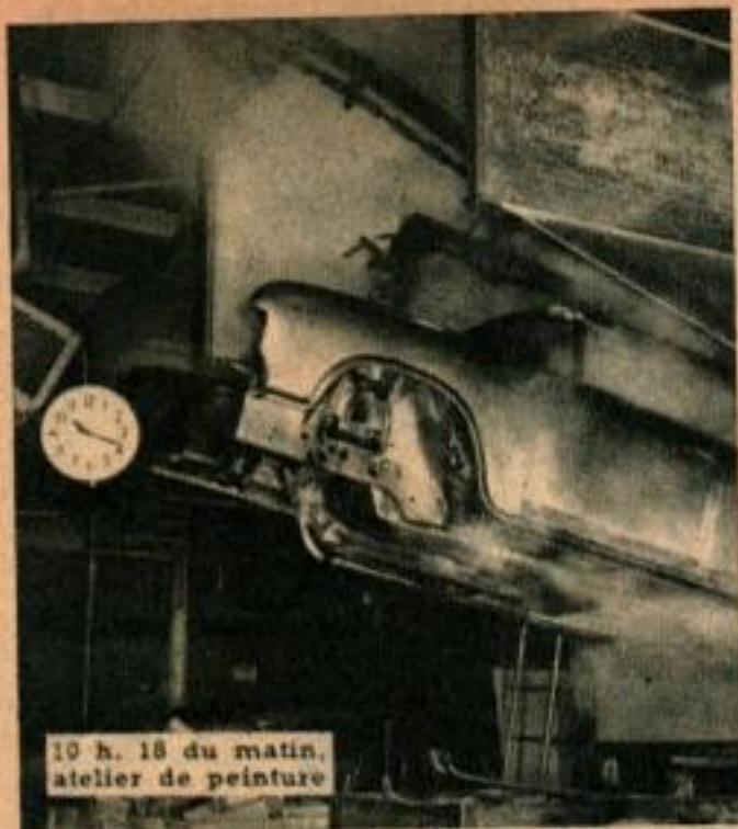
10 h. 18. La tôlerie étant terminée, la carrosserie est nettoyée et traitée par le procédé Parker, avant la peinture.
