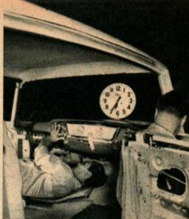
18 h. 35. Le tableau de bord est monté en une seule pièce. Il a été assemblé dans un autre atelier et amené vers la chaîne par un transporteur automatique.
