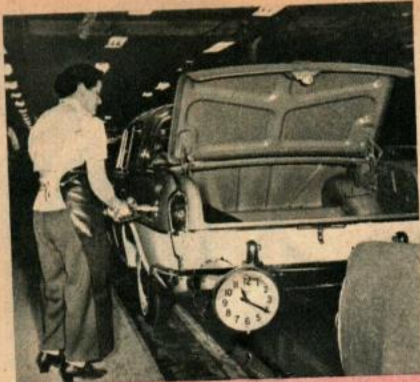
23 h. 20. Les roues touchent le sol. Le réservoir connaît pour la première fois le goût de l'essence, 20 litres environ.
