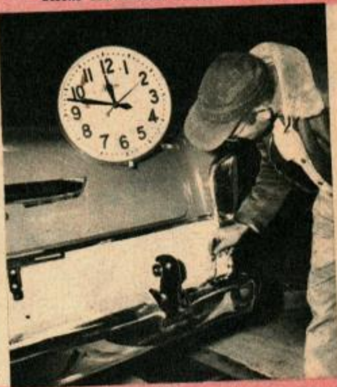
23 h. 48. Inspection finale. Les moindres défauts de peinture sont retouchés tandis que la voiture s'approche de la fin de la chaîne.
