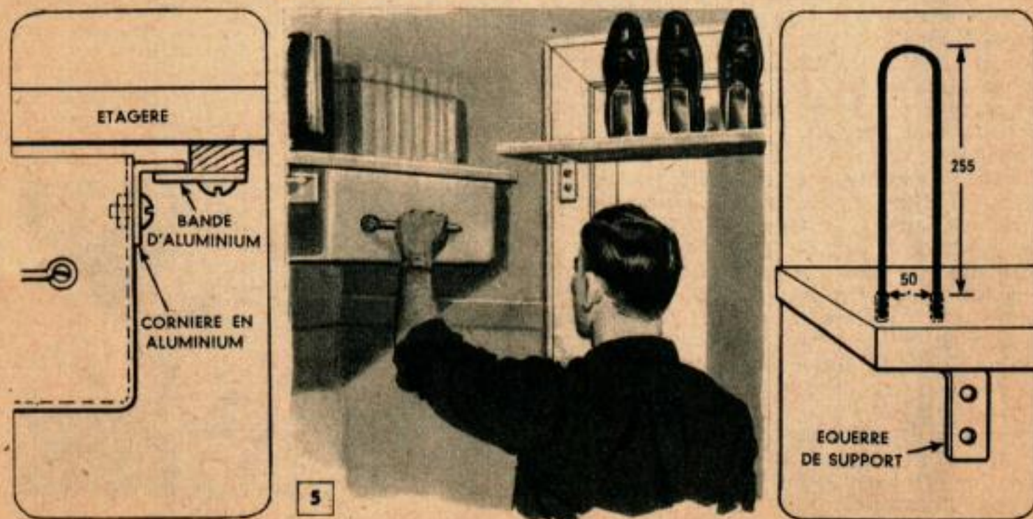
L'espace de cette penderie est complètement utilisé par l'installation d'un tiroir pour les chapeaux et les gants, et par celle d'un râtelier à chaussures sous plafond.
